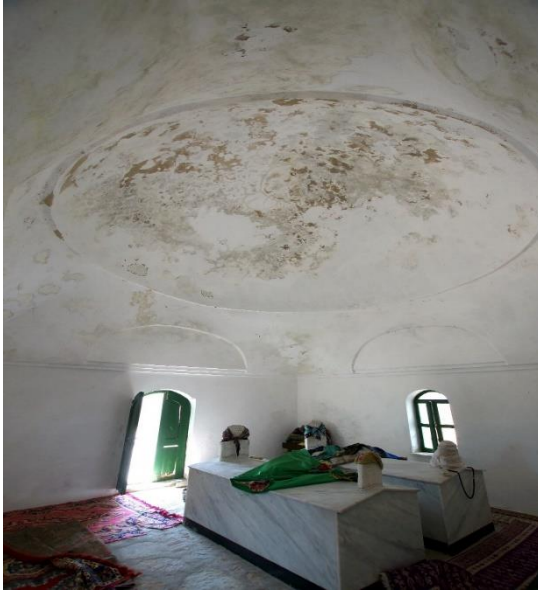
Foto. 21: İç Mekân, Batı ve Kuzey Duvar
