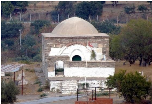
Foto. 4: Türbe Genel Görünüm
