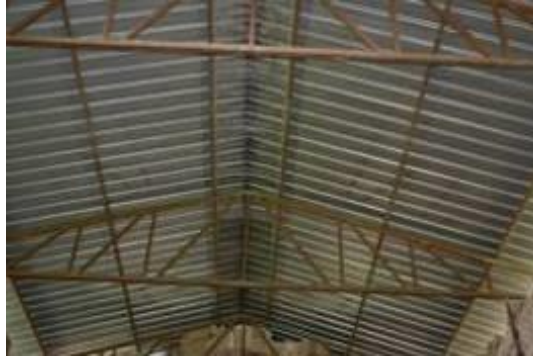
Şekil 15. Katholikonun günümüzdeki örtü sistemi (2022)
