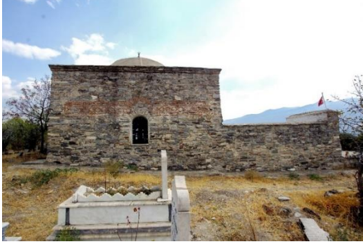
Foto. 11: Kuzey Cephe Genel Görünüm
