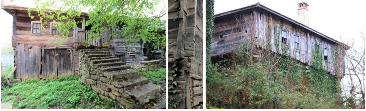
Foto. 5. 1 numaralı evin ön cephesi (solda), Foto 6. 1 numaralı evin kurtboğazı geçmeli ahşap yığma (çantı) duvar ayrıntısı (ortada), Foto. 7. 1 numaralı evin kuzey doğudan görünümü
