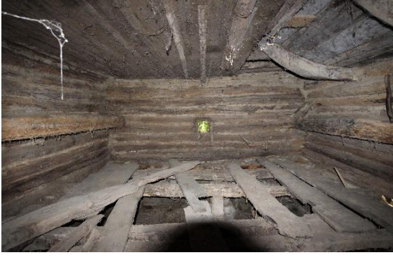
Foto. 11. 1 numaralı evin zemin kat doğu ahır iç görünümü
