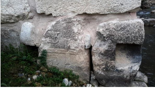
Şekil 7. (Foto: Aktaş, E.) Kurt Köprüsü'nün ayaklarındaki haç motifli pres ağırlık taşı olduğu düşünülen blok.
