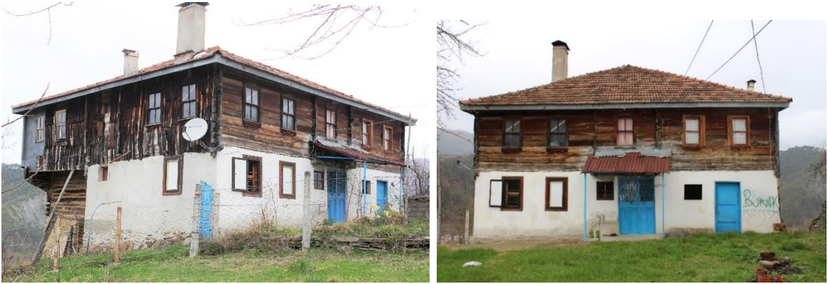
Foto. 76-77. 5 numaralı ev kuzeydoğu ve (solda) ve doğu (giriş) cepheleri
