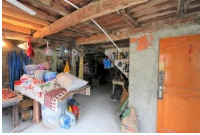
Foto. 57. 3 numaralı ev zemin kat ev altı (batıdaki kapıdan bakış)
