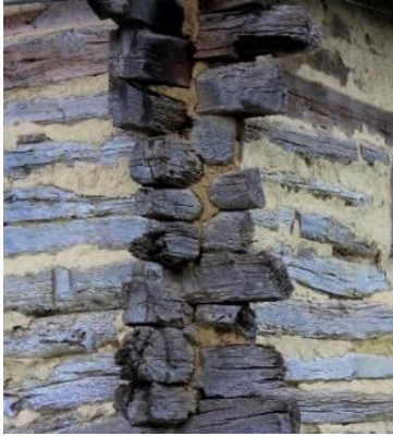
Foto. 73. 4 numaralı ev zemin kat karaboğaz geçmeli ahşap yığma çanti duvar ayrıntısı
