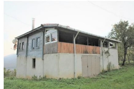
Foto. 86. Güneydoğu (giriş) ve güneybatı cepheleri
