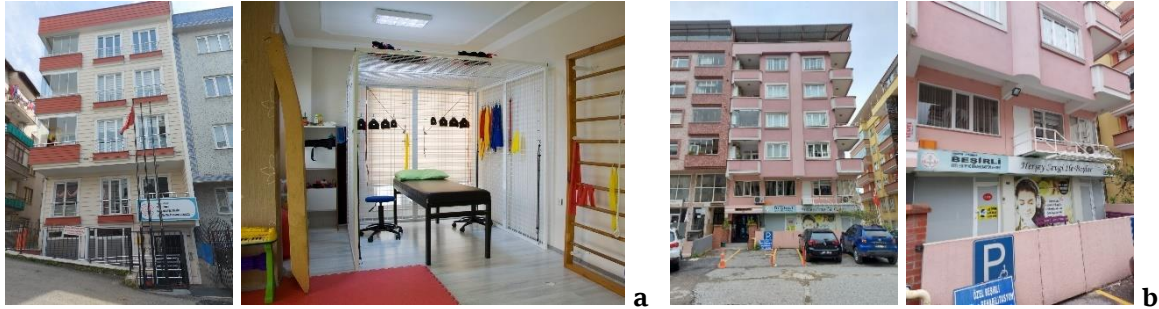
Şekil 17. (a) Özel Çınar Özel Destek Eğitim ve Rehabilitasyon Merkezi, (b) Özel Beşirli Özel Eğitim ve Rehabilitasyon Merkezi (Z. Yanılmaz Arşivi)
