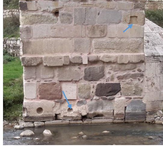
Şekil 8. (Foto: Aktaş, E.) Kurt Köprüsü'nün ayaklarındaki pres ağırlık taşı ve yukarısında üzengide görünen pres ağırlık taşının yan yüzü.
