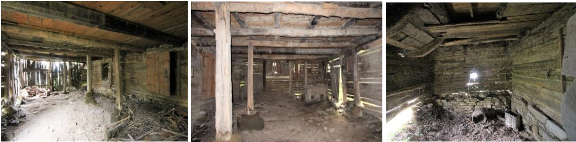
Foto. 8-9. 1 numaralı evin zemin kat ev altı görünümleri (sol ve orta), Foto. 10. Zemin kat batı ahır iç görünümü
