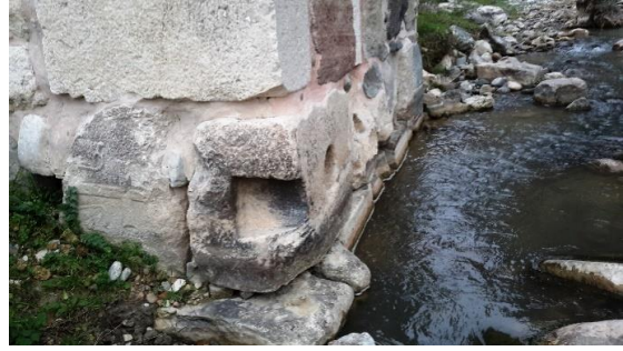
Şekil 6. (Foto: Aktaş, E.) Kurt Köprüsü, köprü ayaklarındaki pres ağırlık taşı.
