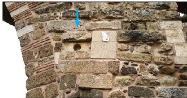
Şekil 10. (Foto: Aktaş, E.) Kurt Köprüsü, köprü duvarlarındaki pres ağırlık taşı.
