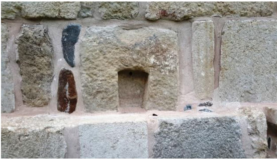
Şekil 9. (Foto: Aktaş, E.) Kurt Köprüsü, yan yüzünde görünen pres ağırlık taşı.
