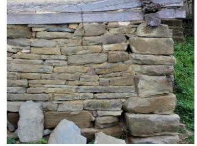
Foto. 72. Subasman kesimi; kuzey cephenin batı kenar ayrıntısı
