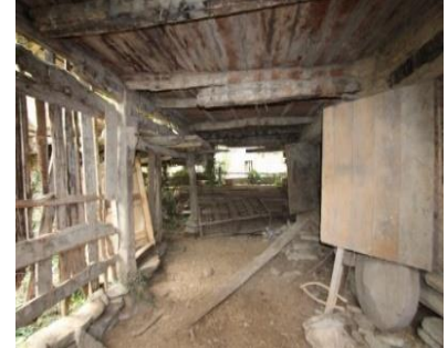
Foto. 41. Zemin kat ev altı bölümüne doğudan bakış
