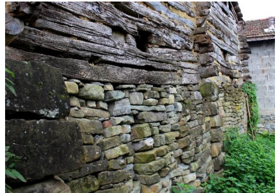
Foto. 104. Ev 9 arka cephe subasman ayrıntısı
