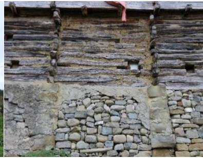
Foto. 52. Güney cephede taş su-basman ve zemin kat duvar ayrıntıları
