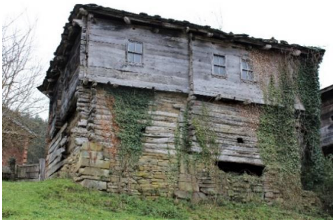
Foto. 40. 2 numaralı ev güney cephe
