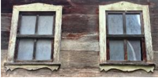
Foto. 34. Dış cephe pencere ayrıntısı
