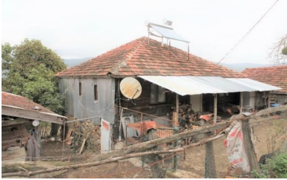
Foto. 93-94. Otmanlı Köyü'nde geleneksel ahşap yığma (çanta) bir ev ön cepheden görünüm (Ev 7)
