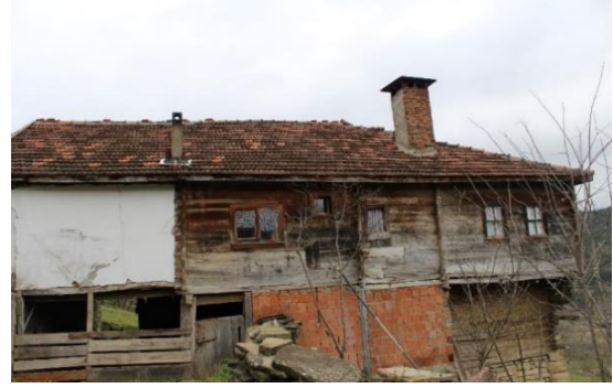
Foto. 106. Otmanlı Köyü'nde geleneksel çantı bir ev (Ev 11 - yan cephe)
