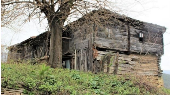
Foto. 36. 2 numaralı ev kuzeydoğudan görünüm
