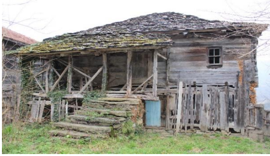
Foto. 38. 2 numaralı ev güney (giriş) cephe
