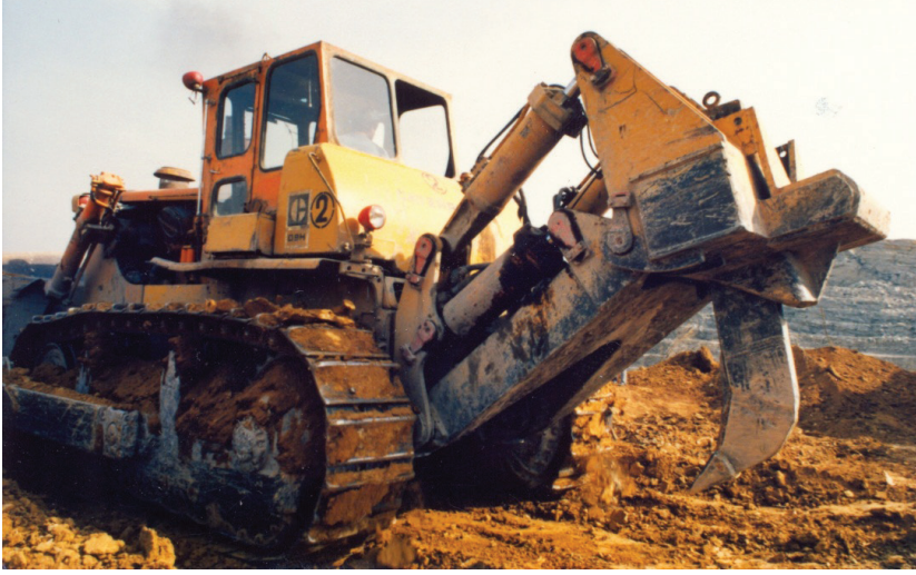
Şekil 1. Örtükazı işlerinde sökme uygulaması
