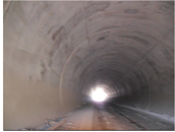
d) Kaplama beton imalatı tamamlanan 31 nolu tünel
