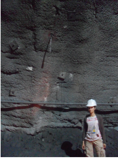
a) 30 nolu Tünelden deformasyon ölçümü alınan nokta Km: 226+890,80
