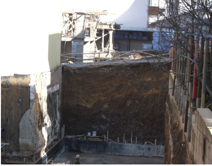
Şekil 12. Pelitli mevkiindeki temel çukuru
