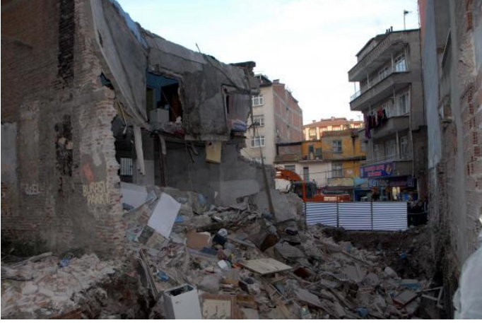
Şekil 30. Samsun Bafra'daki binanın çökmesi
