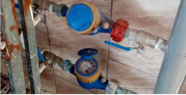
Şekil 10. Yanlış sayaç montaj örneği.
