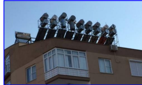
Şekil 6. Sayaç hassasiyetini düşüren güneş panel sistemleri.
