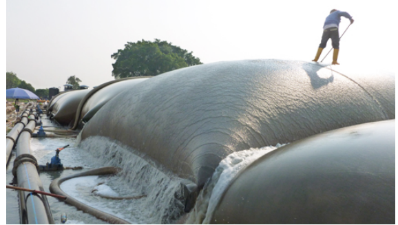
Şekil 16. Jeotekstil filtre ile susuzlandırma işlemi
