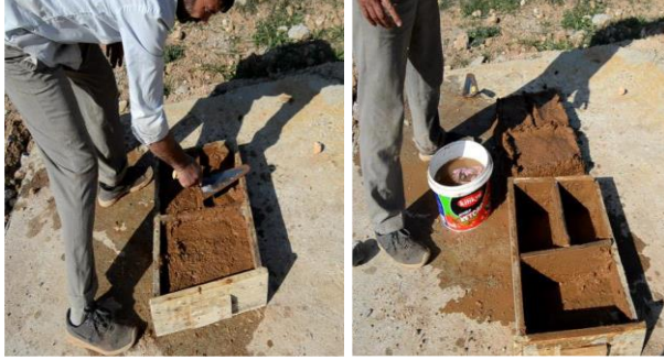
Şekil 5. Ahşap kalıplarla kerpiç blok yapımı, 2019
