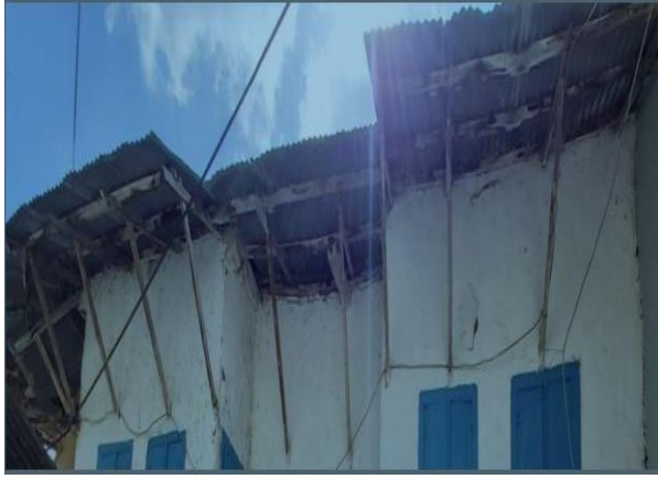
Şekil 13. Malatya Beybağı köyünde sonradan eklenen metal sac üst örtü, 2021
