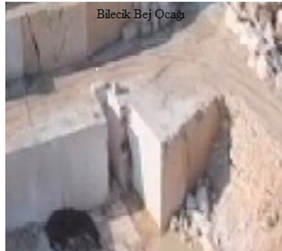
Şekil 8. Yeni kanal açma yöntemiyle açılan U şeklindeki kanal
