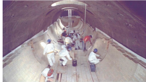
Resim 3. Otoklav içerisine asite dirençli tuğlaların döşenmesi
