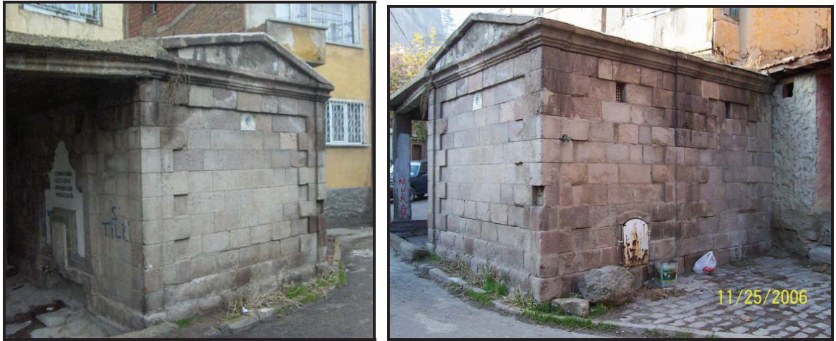
Şekil 3. Arapmescit çeşmesinin görünümü, andezitik kayalardan kesme taş olarak yapılmıştır.
