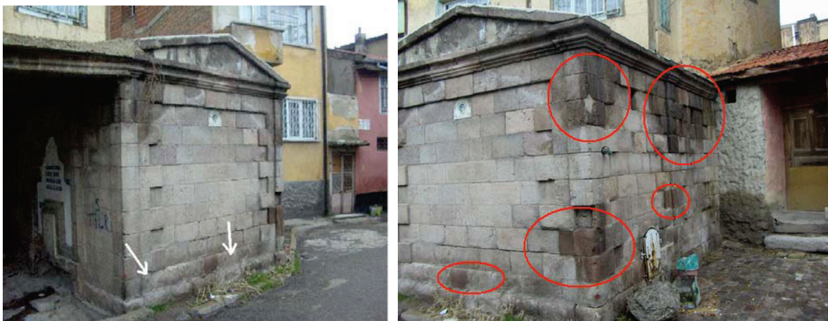
Şekil 12. Arapmescit çeşmesinde kayalarda görülen fiziksel bozunmalar.
