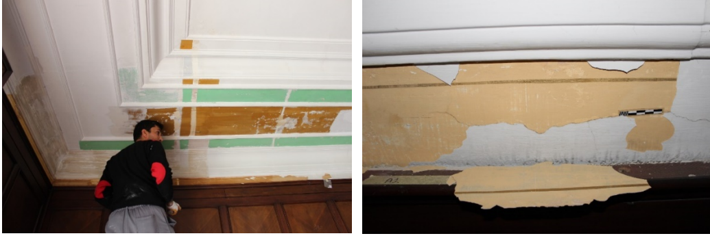
Görsel 20. AÜ GSF Dekanlık Binası Makam Odası Tavan Boya Katmanları (Solda) ve Tavan Duvar Birleşiminde Dekoratif Boya (Sağda) “Duvar Resmi Koruma ve Onarım Dersi Uygulama Projesi-2015” (Kaynak: Cengiz ÇETİN’in Kişisel Arşivi)
