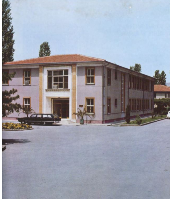
Görsel 12. AÜ GSF Dekanlık Binasının Türkiye Zirai Donatım Kurumu Dönemi Durumu, 1973 (Kaynak: Tarhan vd. 1973, s.9)
