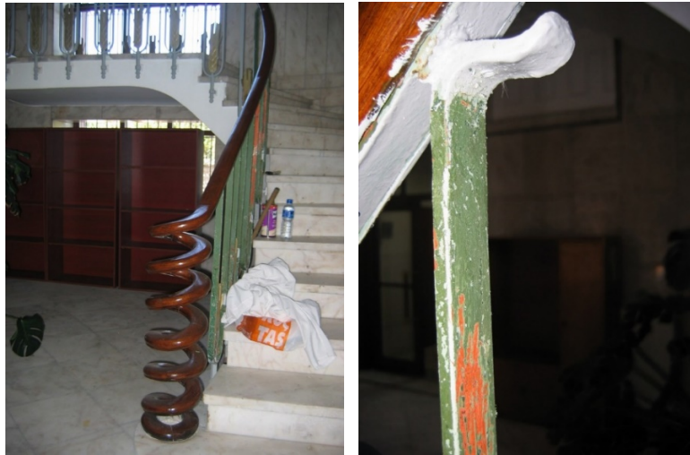
Görsel 21. AÜ GSF Dekanlık Binası Tırabzanlarının Konservasyonu “Metal Koruma ve Onarım Dersi Uygulama Projesi-2014”
