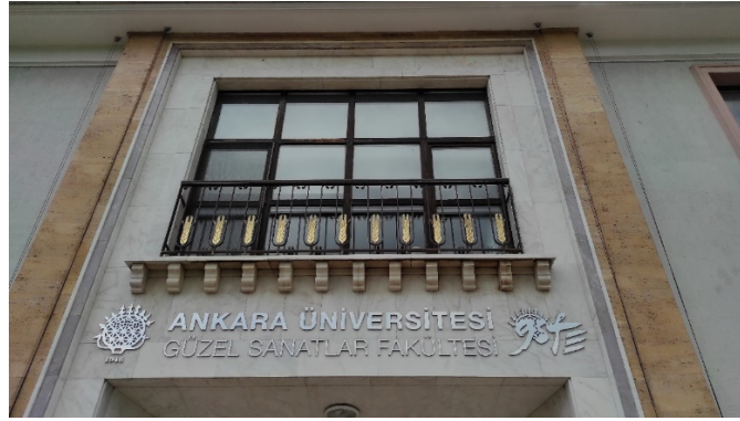
Görsel 22. AÜ GSF Dekanlık Binası Girişi ve Makam Odası Penceresi 2023
