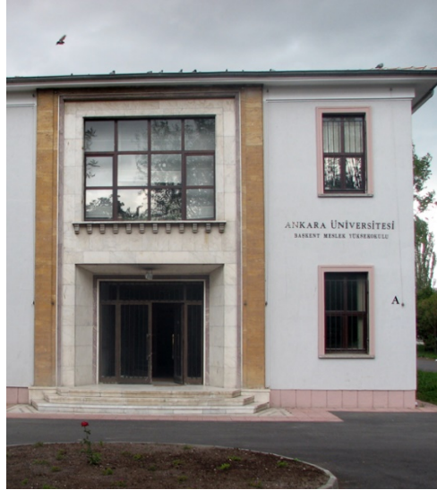
Görsel 25. AÜ GSF Dekanlık Binası Girişi ve Makam Odası Penceresi 2007
