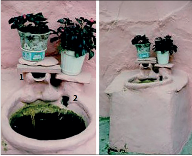
Şekil 5. Geleneksel Bursa çeşmesinin yosun tutmuş haznesi (dağar) 1-suyun gelişi, 2-suyun çıkışı (1998) (Özer, 2001, s.28-29) / Moss-grown reservoir of a traditional Bursa fountain. 1) Water inflow 2) Water outflow. (1998) (Özer, 2001, p.28-29).
