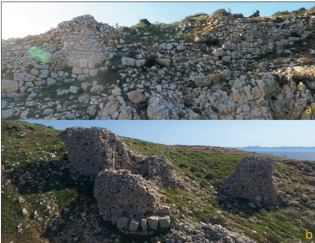
Figür 11. Temel üzeri düzgün ve bosajlı taş sıraları, a) Doğu suru b) Batı suru / Smooth and hollow stone rows on the foundation, a) Eastern wall b) Western wall (Foto / Photo: M. Güngör).
