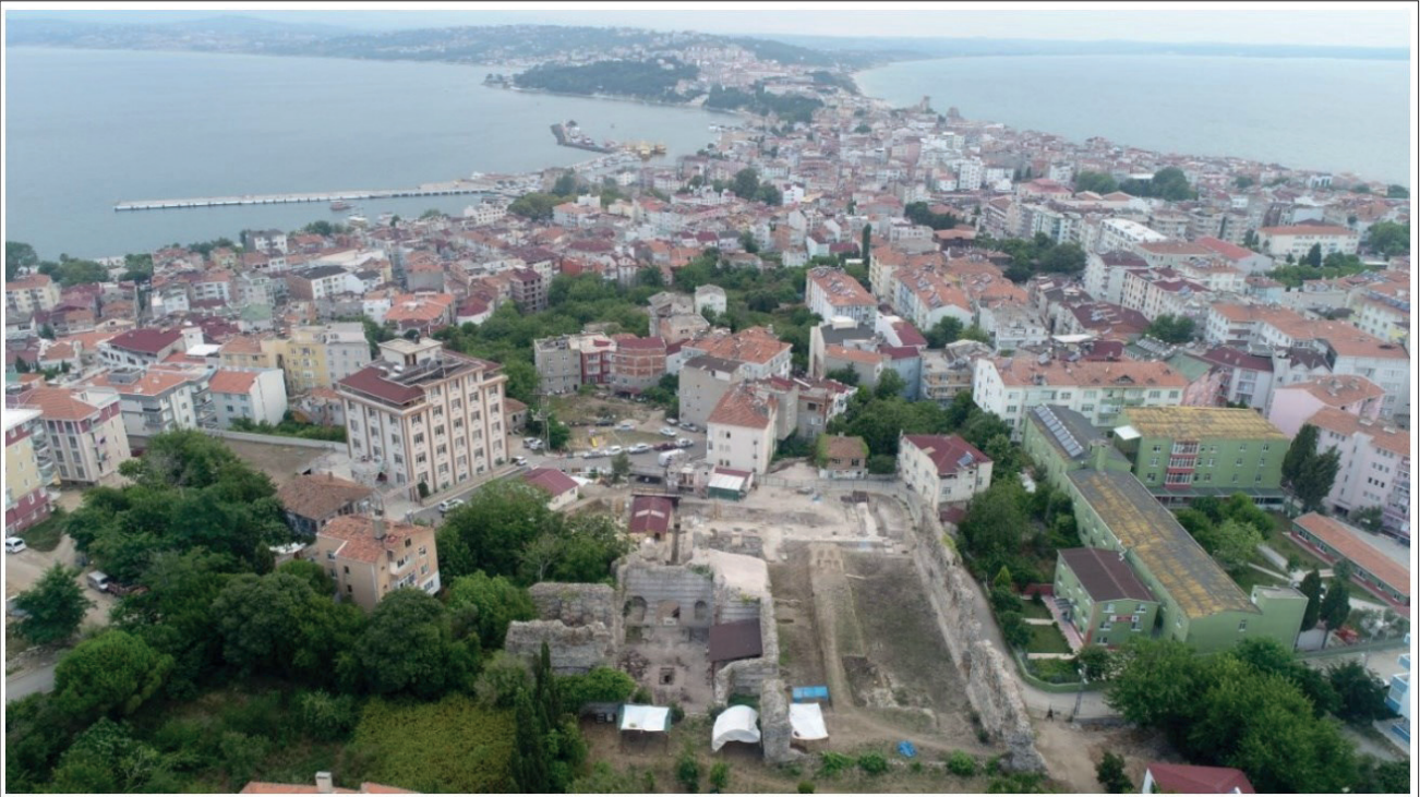
Fotoğraf 1. Balatlar yapı topluluğu havadan görünüm / Balatlar building complex aerial view (SBK Kazı Arşivi / SBK Excavation Archive ).
