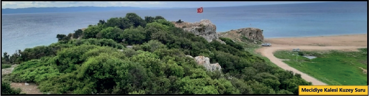
Figür 13. Mecidiye Kalesi a) Kuzey, b) Güney, c) Doğu, d) Batı surları / Mecidiye Caste a) Northern, b) Southern, c) Eastern, d) Western walls (Foto / Photo: M. Güngör).
