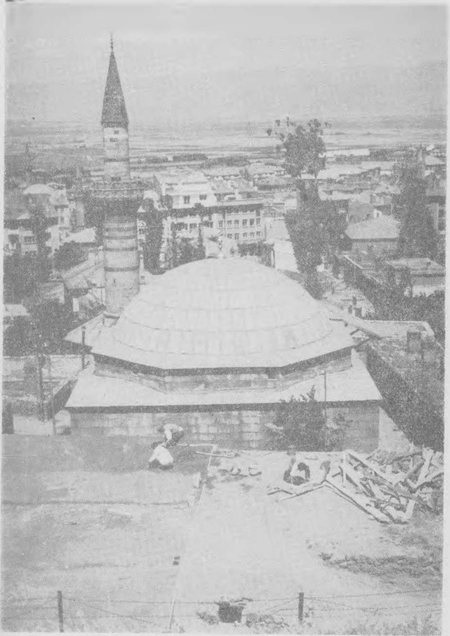
Res. 7- Kurşunlu (Feyziye) Camisi. Güneyden görünüş.
