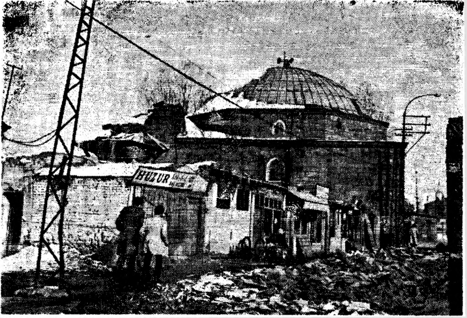
Res. 10- Gümrük Camisi. Batıdan görünüş.
