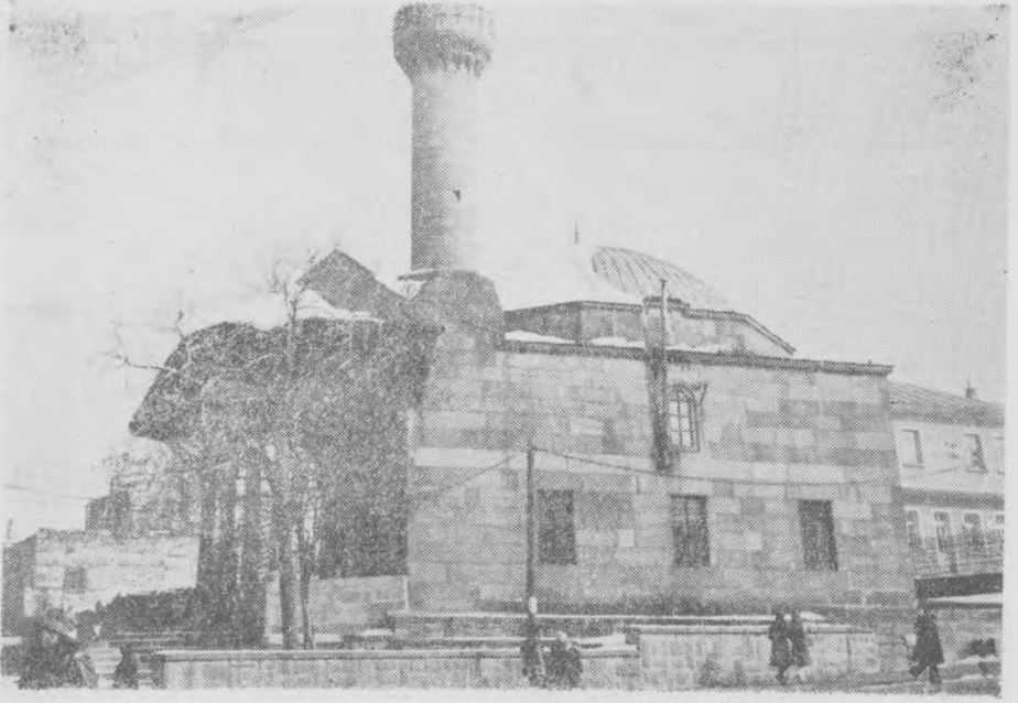
Res. 13- İbrahim Paşa Camisi. Batıdan görünüş.
