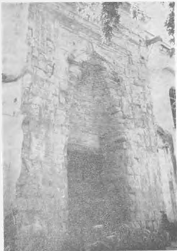
Resim: 1 — Bursa Ulu Câmi tak kapısı.
