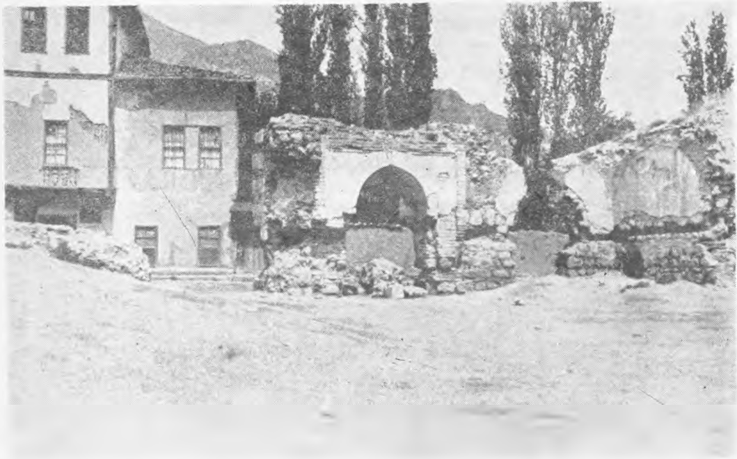
Resim: 12 — Kapu Ađası medresesinin kapısının avlu tarafından grn (tamirden nce).
