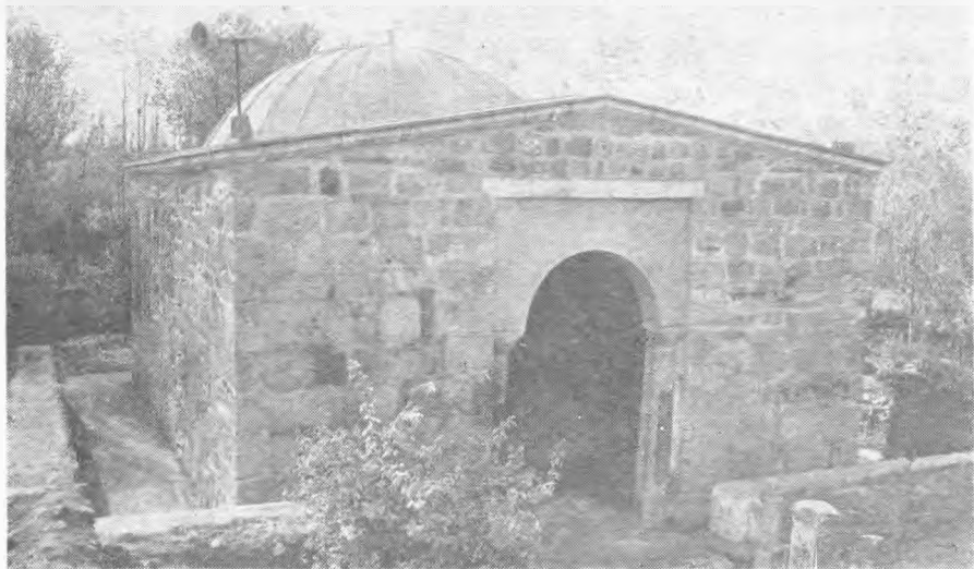
Resim: 5 — Caminin 1976 daki durumu.
