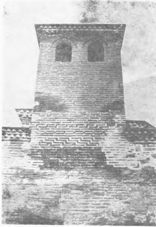
Resim: 13 — Imâretin batı duvarında, arastaya ait olduğu tahmin edilen izler, (1969).
