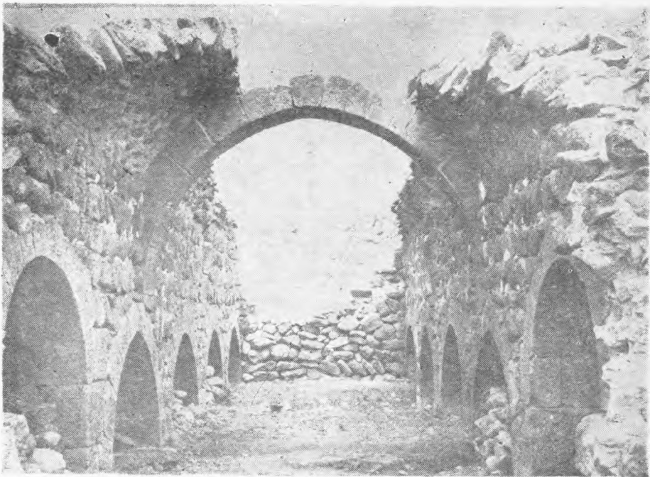
Resim: 3 — Dumlucu Hanı (Divriği-Sivas). Orta Sahının güneyden görünüşü.
