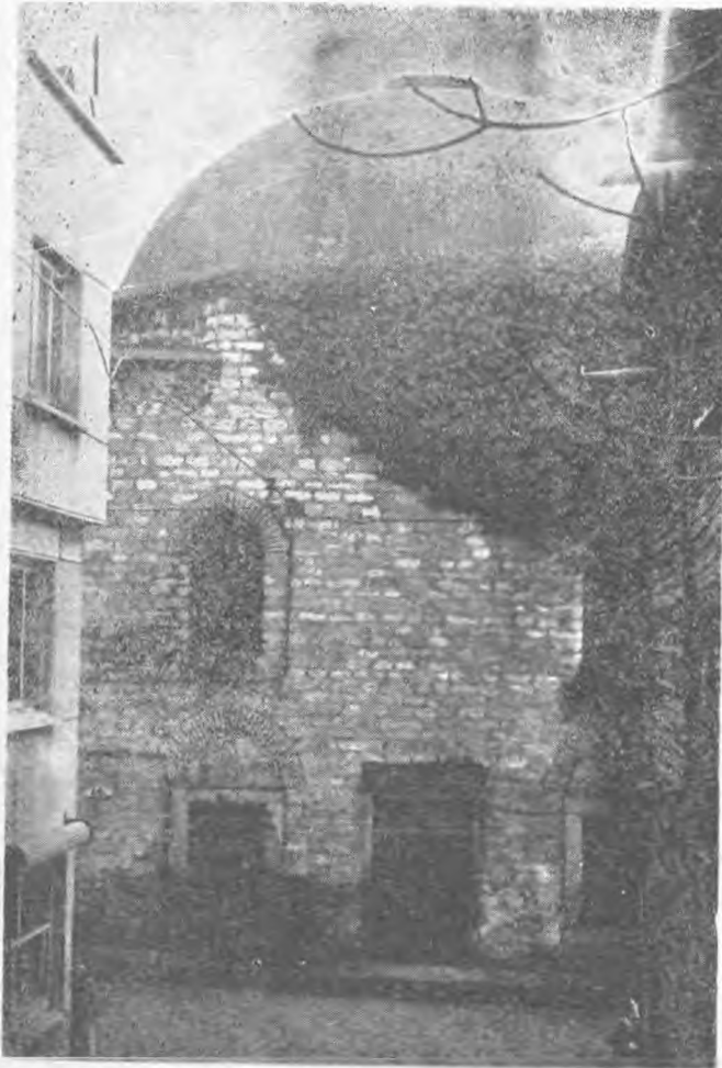
Resim: 71 — Çardaklı hamamın yan cephesi.
