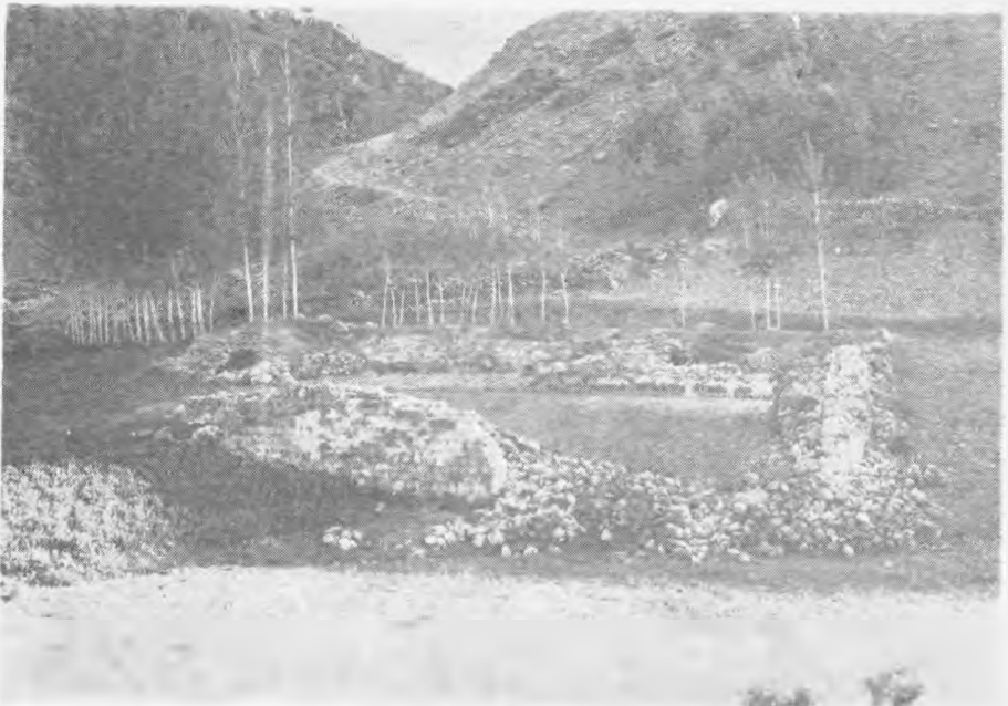
Resim: 7 — Kantarmış Hanı (Arapkir-Divriği). Kuzeyden görünüş.
