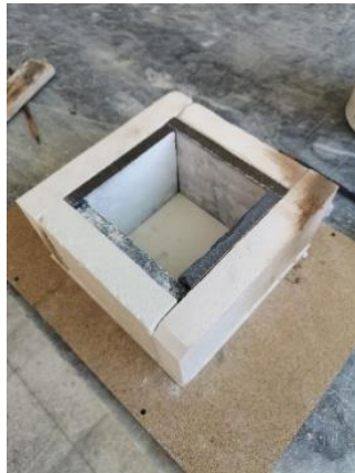
Görsel 2. Hazne 2 yapım aşaması (Kişisel arşiv)
