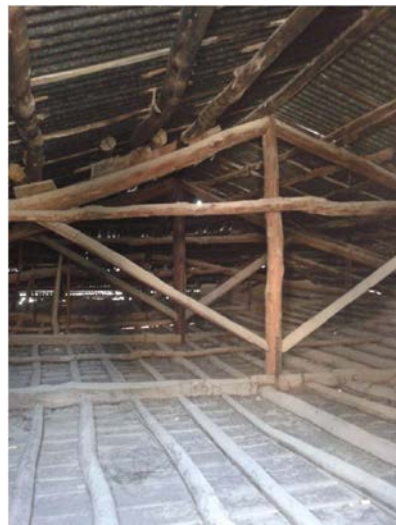
Fotoğraf 10: Harim çatısı ve ahşap hatıl (Pınar, 2014)
