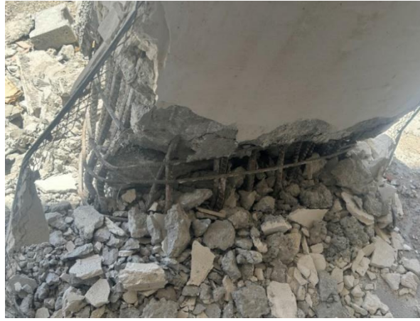
Şekil 12. Enine donatı kolları arası mesafenin yetersiz olması
