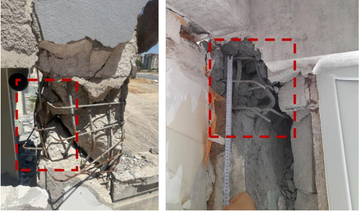
Şekil 11. 90° kanca açısına sahip kolon enine donatılarında açılma
