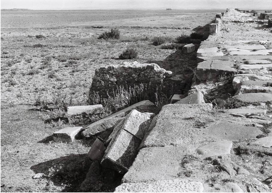
Fotoğraf 33: Restorasyondan önce namazgâh kalıntısı (1982)
