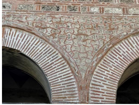
Resim 11: Şehabeddin Paşa Camii'nin son cemaat yeri kemeri arasında görülen tuğla süslemeler. Son cemaat cephesinin kemer üzerinde görülen taşlar arasında tuğlalar dikey şekilde yerleştirilmiştir. Cephenin üstü çift sıra tuğladan kirpi saçakla sona ermiştir.
