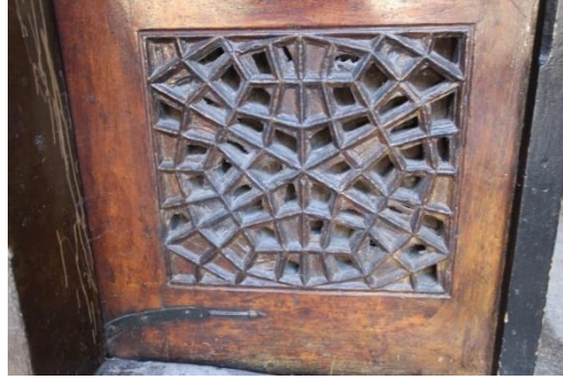
Resim 30: Ahşap kanatların oyma teknikli alt tablası.
