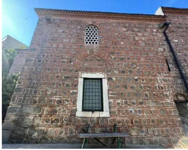
Resim 20: Doğuda yer alan tabhanenin pencere sistemi.
