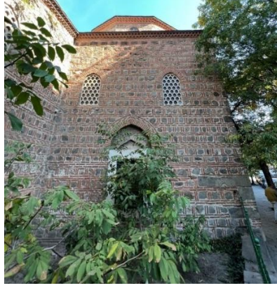
Resim 17: Mihrap önü kubbeli birimin batı cephesi.
