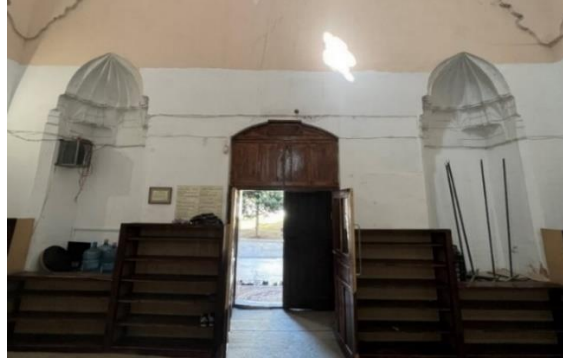
Resim 36: Cümle kapısının her iki yanında bulunan simetrik nişler aslında penceredir.
