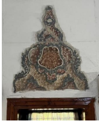
Resim 77: Mihrap önü kubbeli birimde yer alan pencere alınlığında kalem işi uygulamaları.
