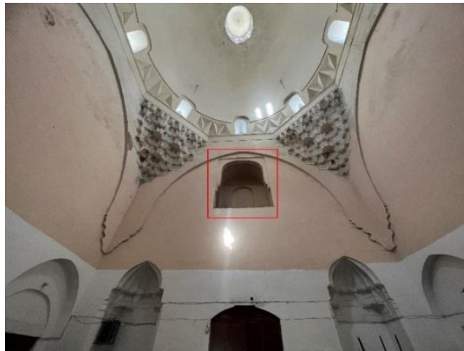
Resim 34: Şehabeddin Paşa Camii.
