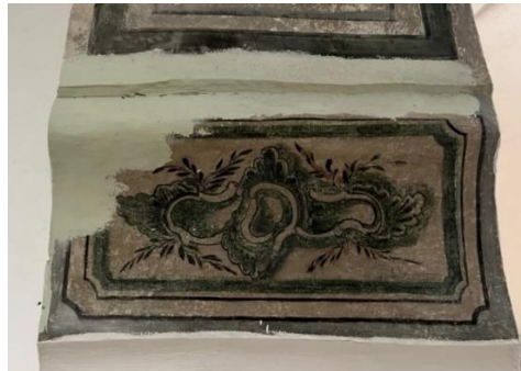
Resim 68: Batıdaki tabhanenin sofaya açılan kemer üzengi taşında kalem işi uygulamaları.
