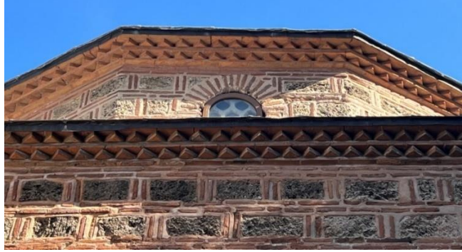
Resim 18: Mihrap önü kubbeli birimin batı beden duvarından detay ve kirpi saçak sistemi.
