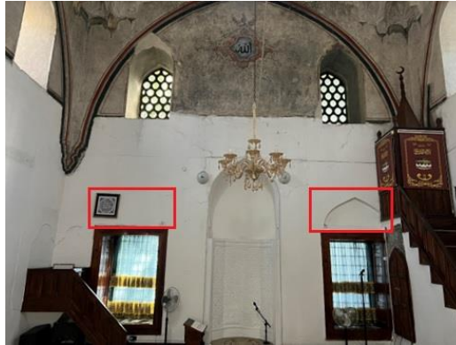
Resim 45: Caminin kible cephesi.
