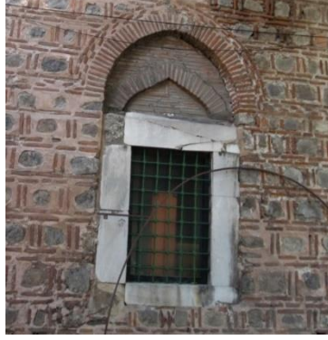
Resim 24: Batı cephedeki alt kat pencere sistemi.
