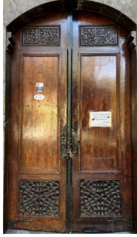
Resim 29: Cümle kapısının ahşap kanatları.
