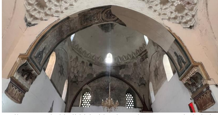
Resim 72: Sofa ile mihrap önü kubbeli birimi bağlayan kemer yüzeyinde kalem işi uygulamaları.
