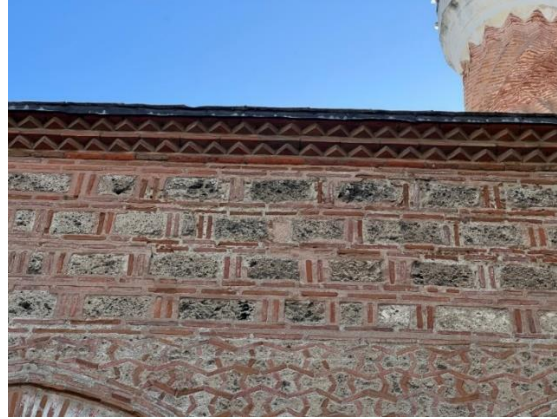
Resim 12: Şehabeddin Paşa Camii'nin son cemaat yeri duvar tekniği detayı ve kirpi saçak. Son cemaat yeri beden duvarlarında farklı dönemlere ait çeşitli sıva izleri bulunmaktadır. Beden duvarında sivri kemerli mihrabiye nişi bulunmaktadır. Üst örtü sistemini taşıyan kemerler arasında üzengi taşı hizasında ahşap gergiler görülmektedir. Zemin altıgen formu (şeshane) tuğlalardan oluşmaktadır.
