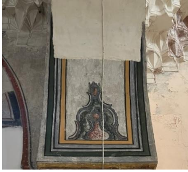
Resim 74: Sofa ile mihrap önü kubbeli birimi bağlayan kemer yüzeyinde kalem işi uygulamaları.
