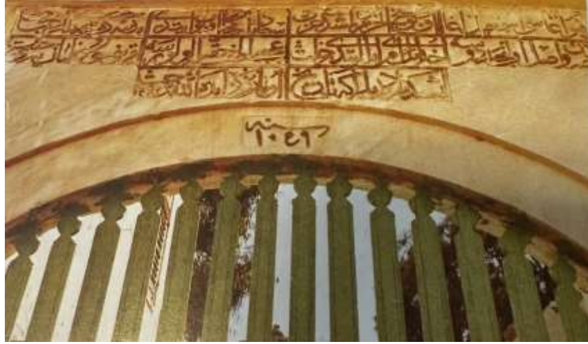
Resim 2. Şahin Giray Han Haziresi Duvar Kitabesi 45
