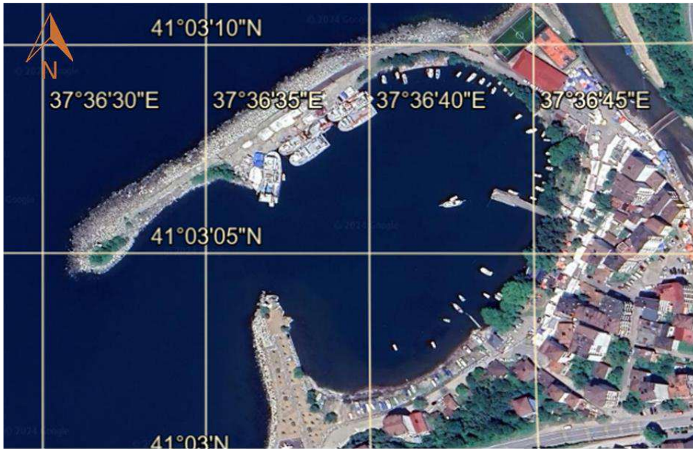
Şekil 7. Yalıköy Balıkçı Barınağı (Google Earth).
