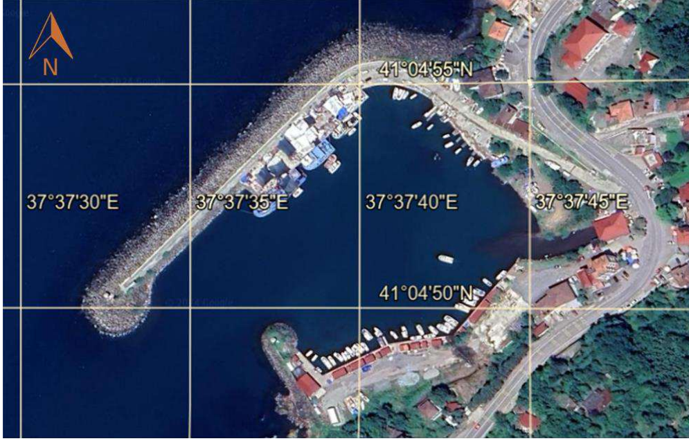
Şekil 6. Medreseönü Balıkçı Barınağı (Google Earth)
