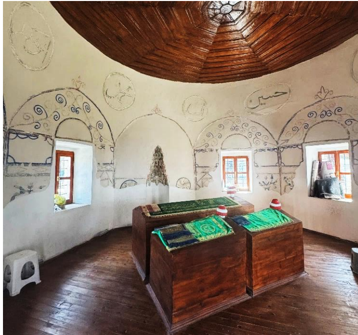
Fot. 29: Türbenin restorasyon sonrası güney kesimi.
