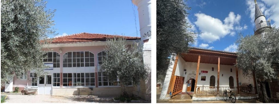
Fot. 18-19: Hüsamettin Efendi Camii'nin batı cephesinden restorasyon öncesi (06.03.2014) ve sonrası görünümü.
