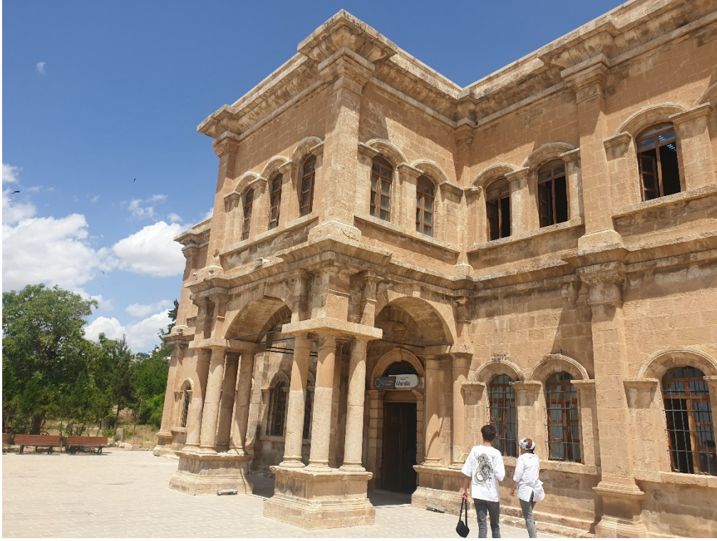
Şekil 10: Mardin İdadi Binası Ana Cephe Genel Görünümü (Yazar Arşivi)
