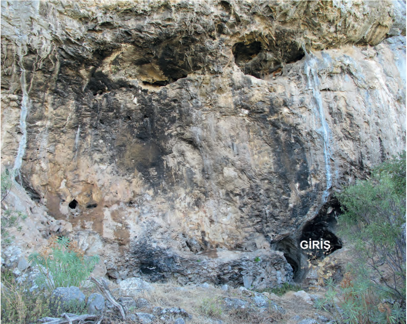
Res. 6. Tavabaşı Aşağı Mağara Girişi ve Aşınmış Düz Yüzeye Sahip Ön Cephesi / Façade of the Lower Cave with Rock Paintings at Tavabaşı.
