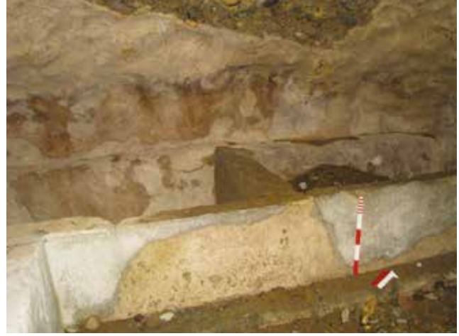
Resim 19: 1 ve 2 no’lu Bölme Duvarlarının Görünümü / A View from the Walls of Compartments 1 And 2
