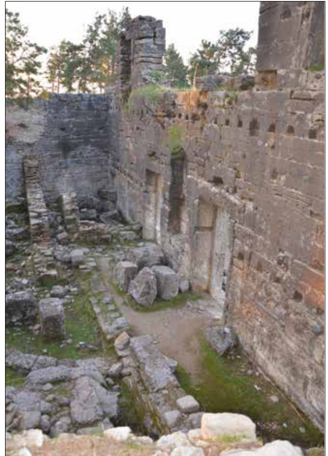
Resim 5: İç Cephe ve Yuvalar / The Interior Wall and Hollows (N. Yıldırım)
