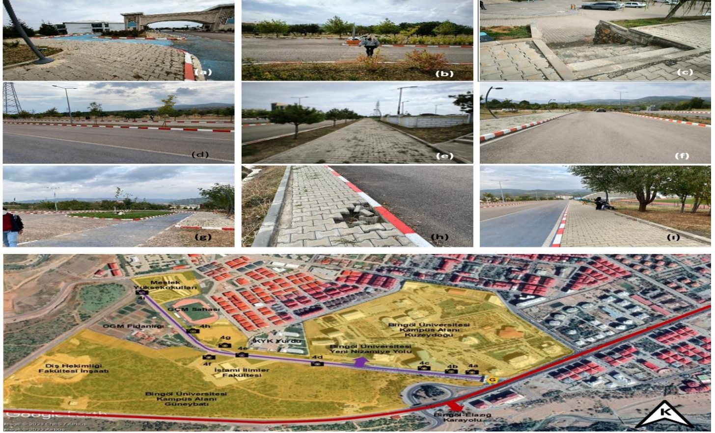
Şekil 4. Alandaki erişilebilirlik noksanlıklarını gösteren fotoğraf örnekleri: (a) Kaldırım başlangıç ve bitimindeki rampa noksanlığı, (b) Refüjde yaya geçiş boşluğu noksanlığı, (c) Merdivenler ile birlikte uygun rampa kullanılmaması, (d) Motorlu taşıt kullanımını teşvik eden çift şeritli ve çift yönlü yol, (e) Kaldırım kilit taşlarının arasındaki temizlenmesi gereken yabancı otlar, (f) Şeridi ters kullanan otomobil sürücüsü, (g) Donatı noksanlığından kaynaklanan kullanımlar, (h) Yapısal hasarlar, (i) Donatı noksanlığından kaynaklanan kaldırım kullanımları ve fotoğrafların çekildiği noktaları gösteren harita
