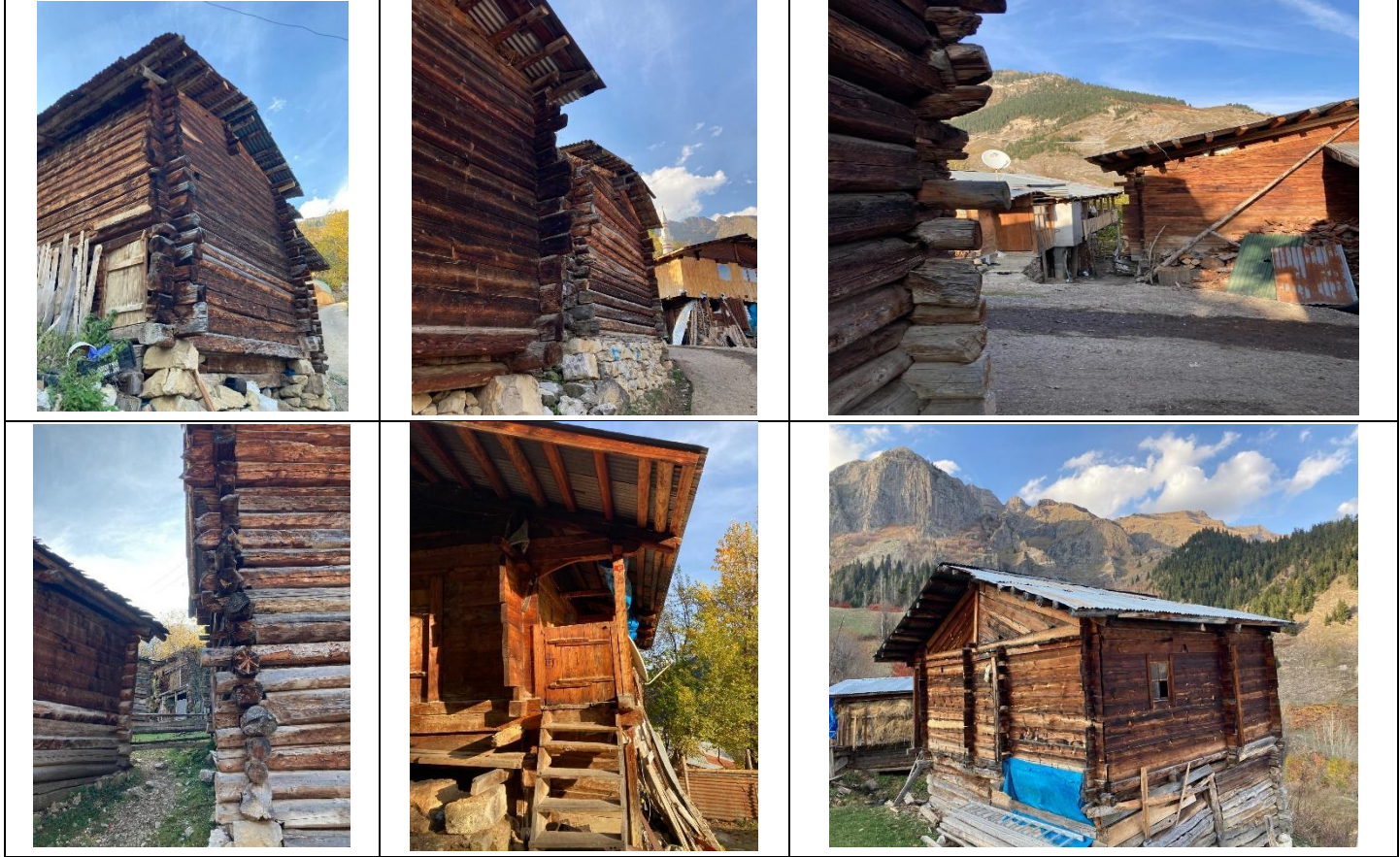
Şekil 9. Geçme teknikleri-Şavşat'ın Maden köyü (Foto: Sorumlu Yazar tarafından çekilmiştir)
