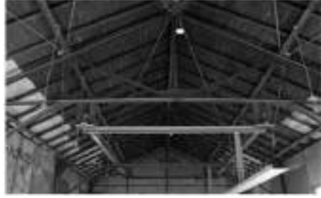
Görsel 29. Atölye tavan görünüşü cephesi Emre Arolat Arşivi. Erişim: 25/10/2013. ( http://www.emrearolat.com ).
