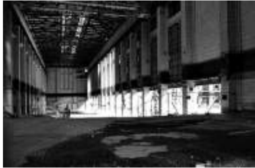
Görsel 6. Bankside santrali iç mekan-atıl duruma düştükten sonra türbin salonunun durumu Urban75. Erişim:25/10/2013, ( http://www.urban75.org/london/battersea-power-station.html ).
