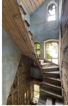
Fotoğraf 21: İkinci kata geçişi sağlayan ahşap merdiven
