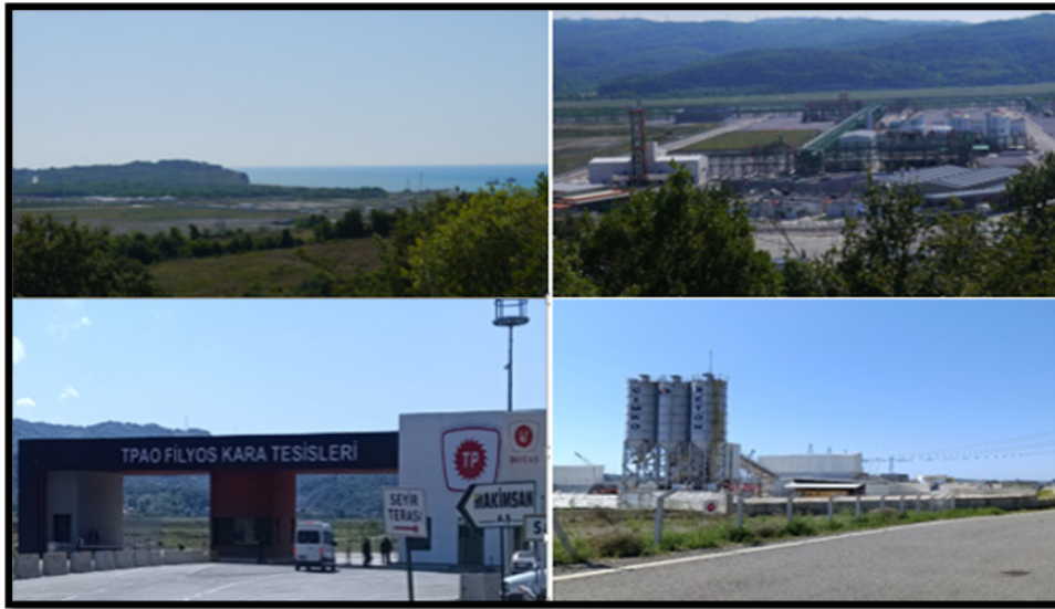
Foto 2. TPAO Filyos Limanı Kara İşleme Tesisleri.
