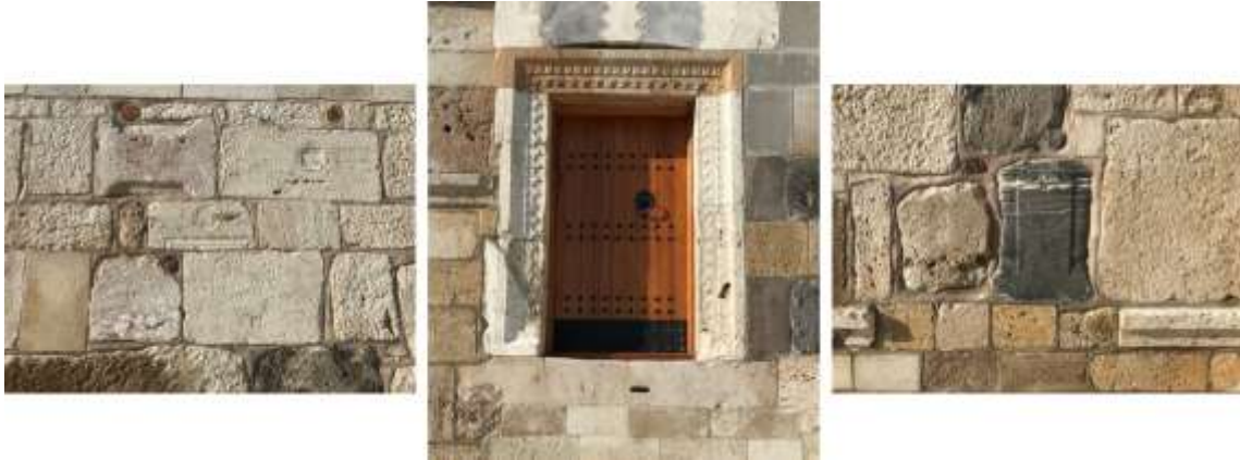
Resim 4. Konya Alâeddin Cami cephesinde yer alan devşirme malzeme uygulamaları (Kişisel arşiv, 2021).
