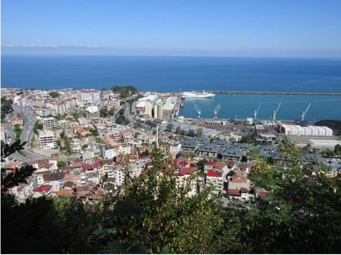
Şekil 21. Çömlekçi Mahallesi kentsel dönüşüm alanının güneyden görünüşü (Selin Sur, 2025)
