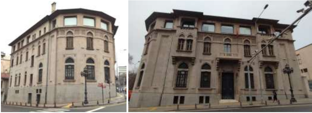
Şekil 1: Ankara Osmanlı Bankası Binası (Yazarların arşivi).
