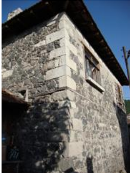
Şekil 1. Kaba yonu taş duvar örgüsü, Dursunbey Kireç Köyü (Çorapçıoğlu ve diğerleri, 2010b)
