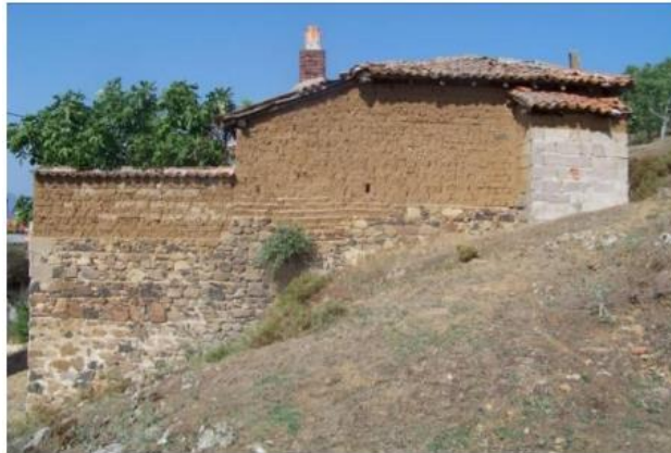
Şekil 3. Moloz taş üzerinde kerpiçten yapılmış duvar örneği, Havran Küçükdere Köyü (Çorapçıoğlu ve diğerleri, 2010b)
