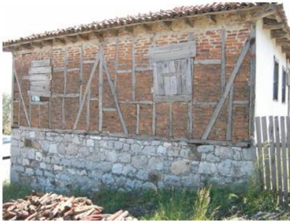
Şekil 4. Moloz taş üzerinde ahşap karkas kurgu içinde tuğla dolgulu konut örneği;Gönen Pehlivanhoca Köyü (Çorapçıoğlu ve diğerleri, 2010b)
