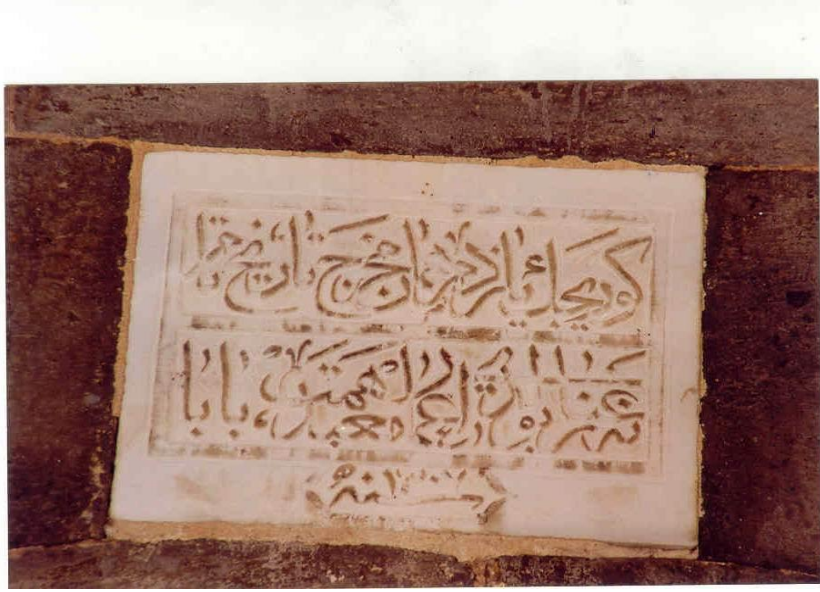
Resim 7: Elbistan Ümmet (Babaiyye–Himmet) Baba Camii, tamir kitabesi.
