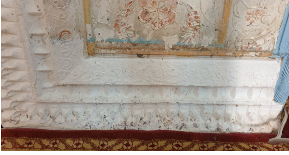
Şekil 25. Böcek Camii Mihrabı, Tuzlanma (Sağ)
