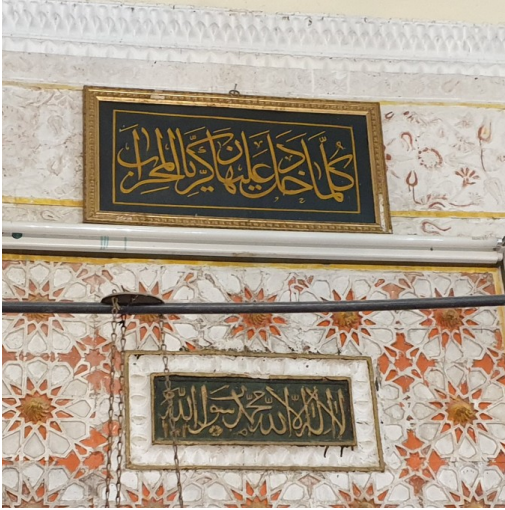
Şekil 32. Böcek Camii Mihrabı, Alçı Bordüre Çivi Çakılması (Sağ)
