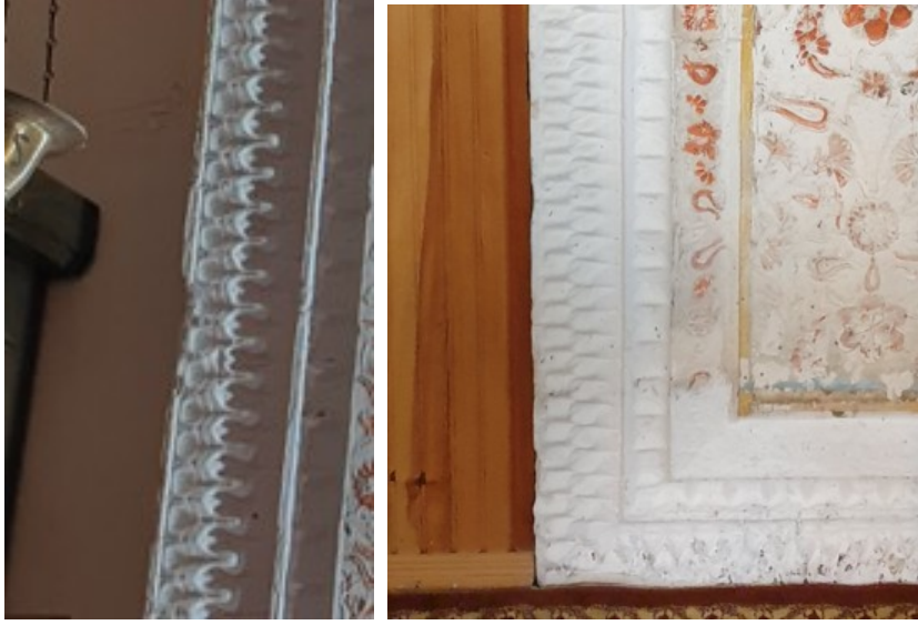
Şekil 22. Böcek Camii Mihrabı, Parça Kaybı (Sol)
