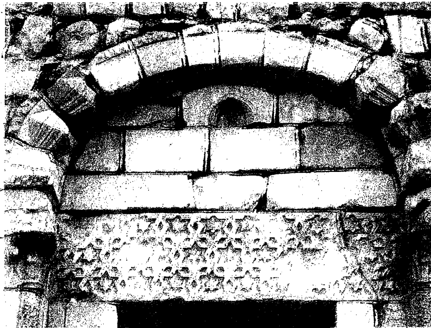
Abb. 11: rechte Fenster oben, Eingangsseite, G
