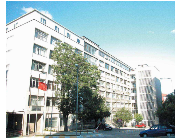
Resim Y. İÜ Diş Hekimliği Fakültesi’nin Gureba Yerleşkesi’nde bulunduğu bina.
