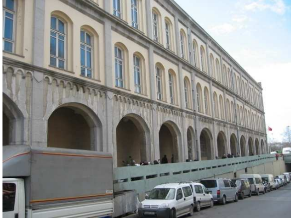
Resim U1. Eski Jandarma Komutanlığı binasının Bakırcılar Caddesi’nden görünüşü (2008).
