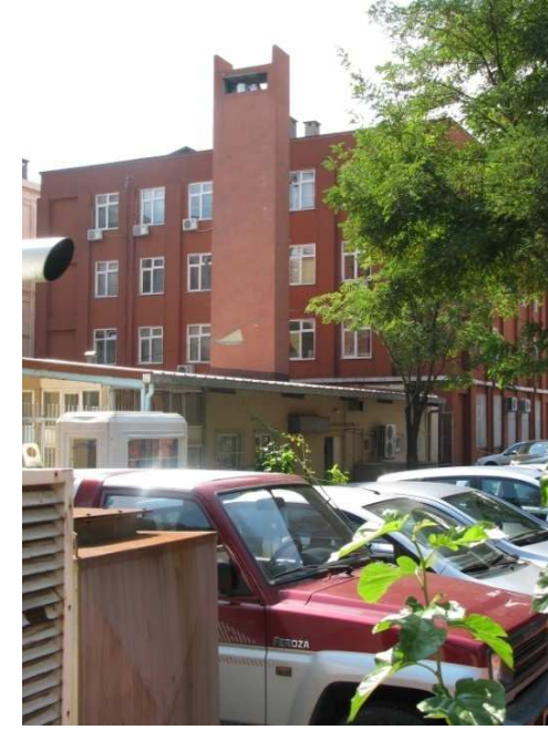
Resim V. Diş Hekimliği Fakültesi’nin 1965-1969 Yılları arasında bulunduğu Keçecizade Fuat Paşa Konağı (C) bloğu 1970 yılında yıkılmış ve arsası üzerine resimdeki bina yapılmıştır. (2009).
