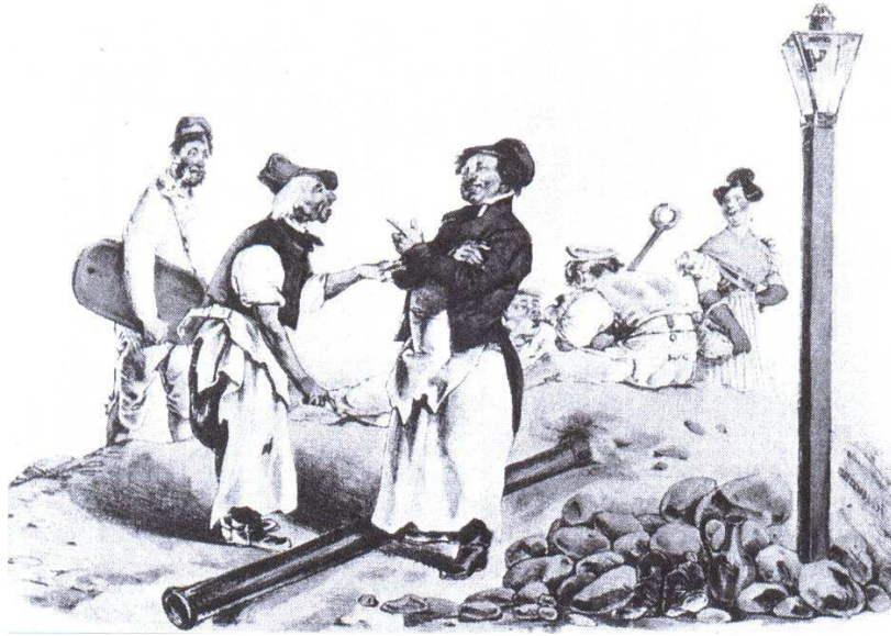
Şekil 6. 1825/26’da Berlin sokaklarında havagazı borularının döşenmesini konu alan dönemin bir karikatürü. (Osteroth, s. 59).
