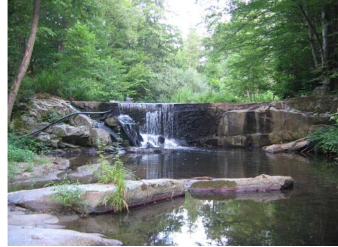
Resim1. Dökümhane çarkına su sağlayan bent
