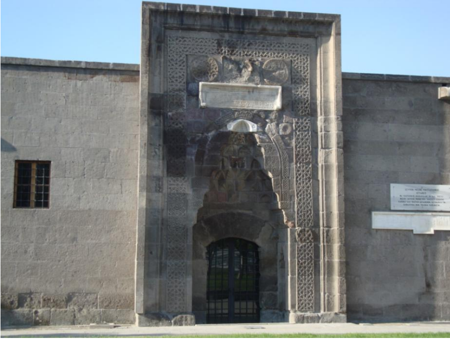
Fotoğraf 3. Kayseri Gevher Nesibe Darüşşifası, Taçkapı
