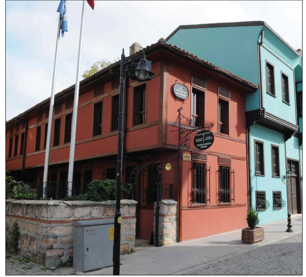
Fotođraf 2. Birim Binası ( ndeki koyu renkli bina)
