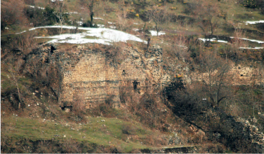
F. 28- Yapının kulelerle tahkim edilmiş gney cephesi (2012)
