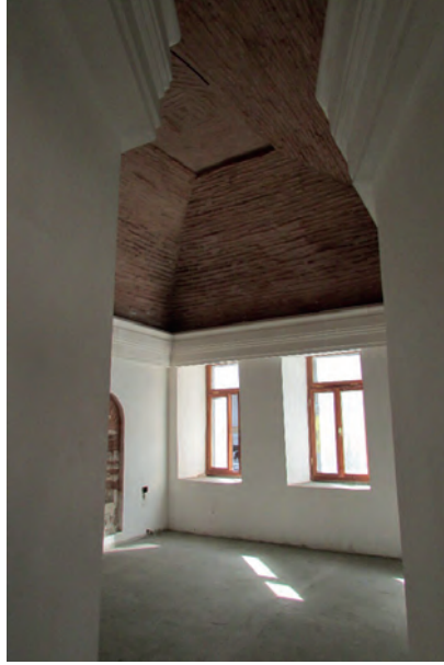
F.8- Tuđla tonoz örtülı üst kat odası, (2012)
