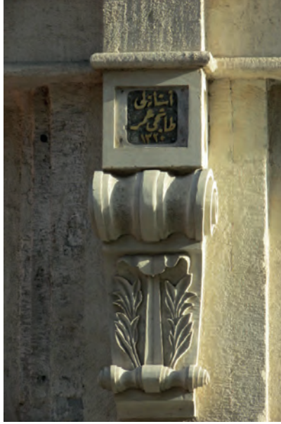
F.14- Güney cephesinde“Asitaneli Taşçı Ömer, 1320” Yazısı (2012)
