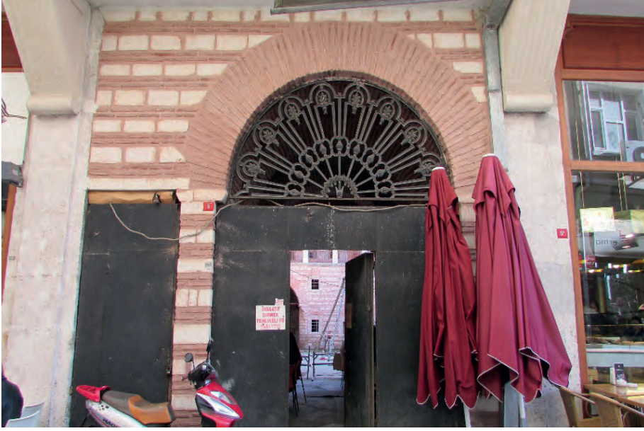
F.16- Batı cephesi giriş kapısı, (2012)
