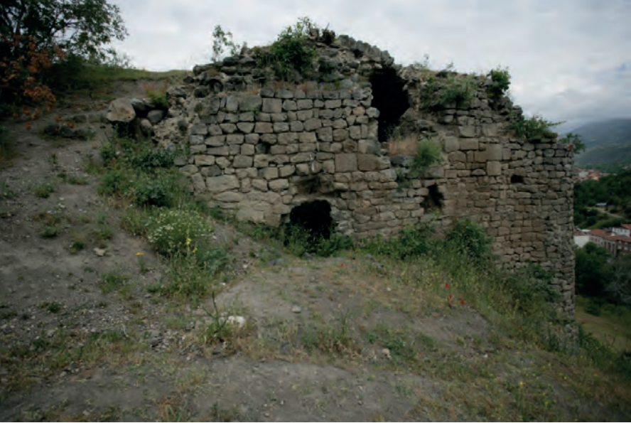
F. 26- Yapının batı cephesi (2012)
