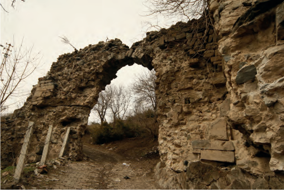
F. 12- Aynalı Burç'un yakınındaki kapı (2012)
