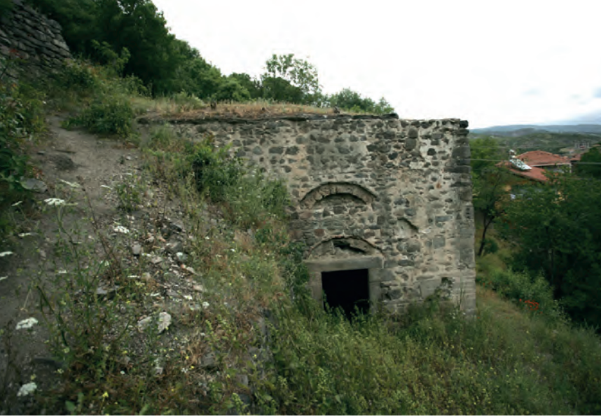
F. 23- Kilisenin batı cephesi (2012)
