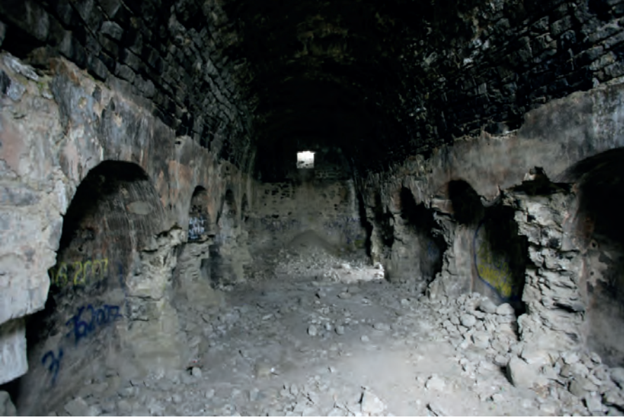
F. 27- Yapının ii ve duvarlardaki nişler (2012)
