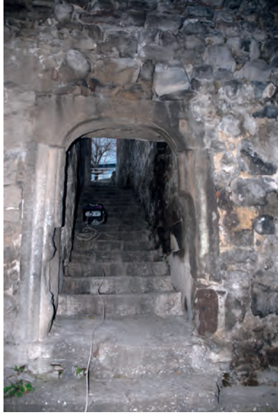
F. 15. Güney suru üzerindeki en batıdaki kapı (2012)
