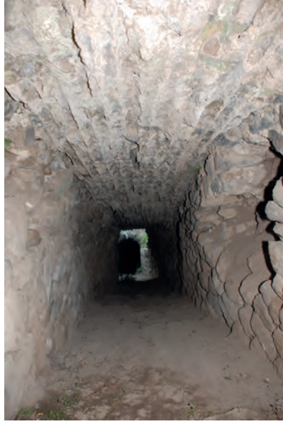
F. 9- Maduru Çayı'na inen dehliz (Niksar Belediyesi Arşivi)
