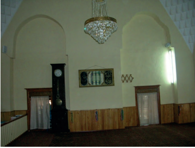
F.10- Edremit Kurşunlu Cami. Onarım öncesi harim.
