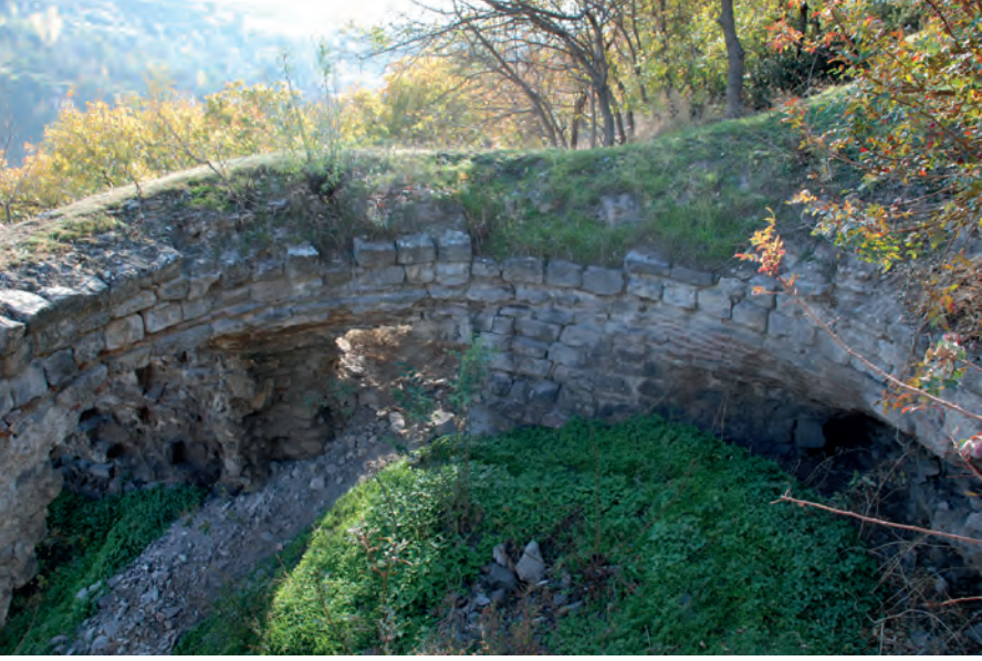
F. 25- Kilisenin yakınındaki yapı kalıntıları (2012)
