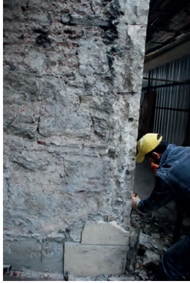
F.20- Kesme tař kaplama altında özgün duvar cephesi, 2008 (İstanbul IV. Numaralı K.V.K.B.K. Müdürlüğü Arřivi)
