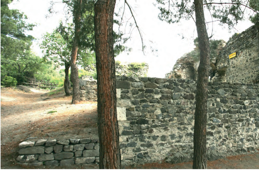
F. 22- Kale Hamamı'nın batı cephesinden bir görünüş (2012)
