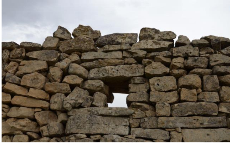
Şekil 7. Taş Duvar ( Kal-a-tul Üstad )
