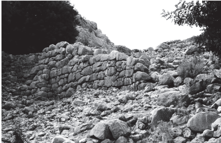
5. Stützmauer der großen Rampe beim Meilenstein CXXXX.
