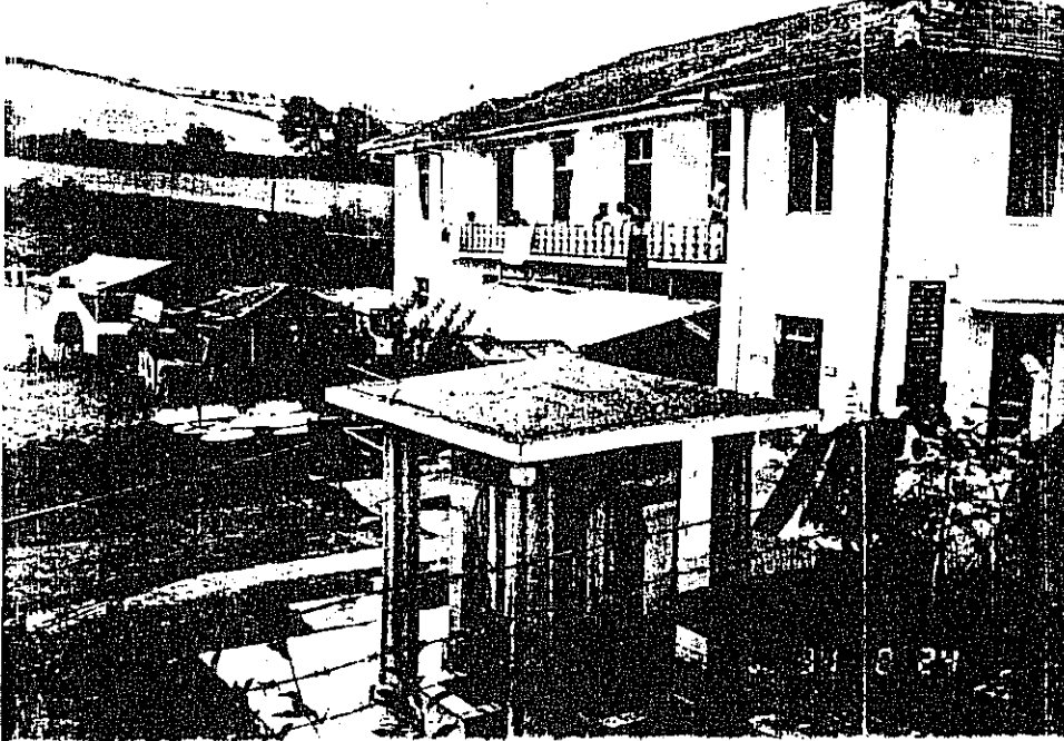
Foto:2-Kaplıca tesislerinin üsti katları konaklama amacıyla kullanılmaktadır.
