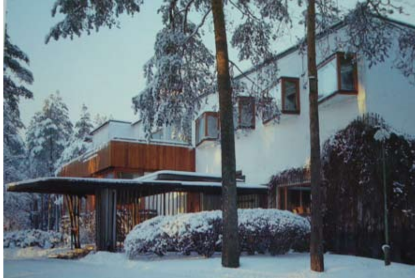
Resim 22. Giriş Cephesinden Görüntü 1 (Weston, 1992)
