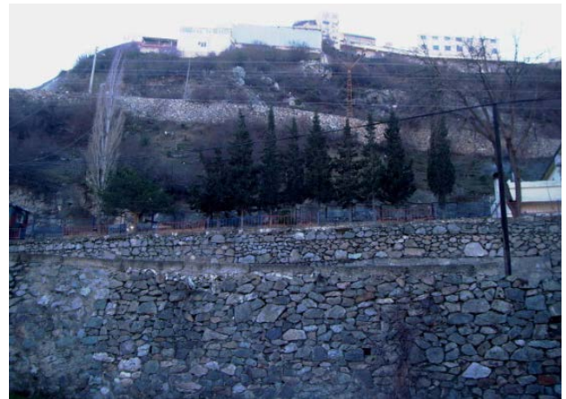
Şekil 7. Kent merkezinde bulunan istinat duvarlarından bir görüntü
