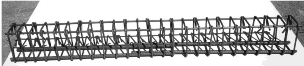
Şekil 2.1 Kirişlerde kullanılan donatının teşkili
