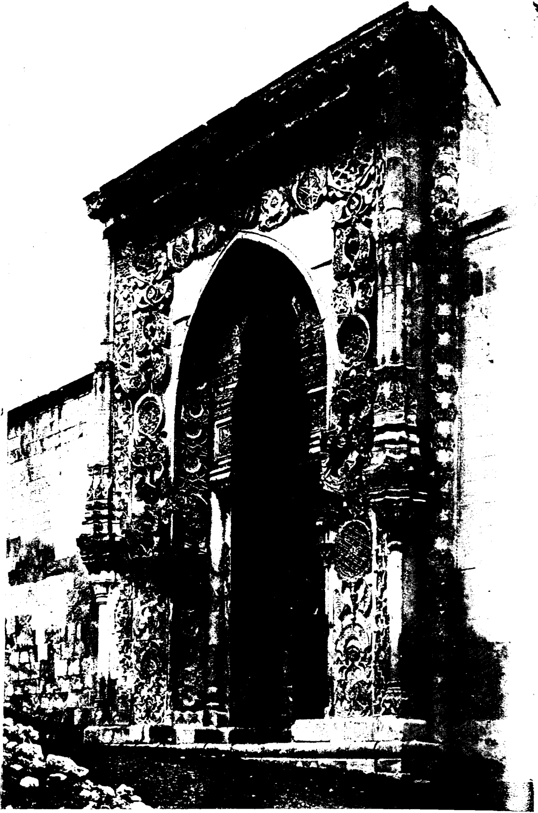
23 — Divriki: Ulucami şimal cephesine düşen cümle kapısı.
