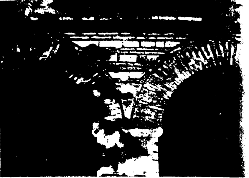
65 — Fatih medreselerinden birinde kemer ve duvar inşaatı. Tuğla ve taş işçiliği yalnız dahilde tatbik edilmiştir. Harici duvarlar adi kesme taştan yapılmıştır.
