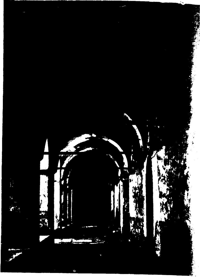
61 — Fatih medresesinin iç avlu revaklarından biri.
