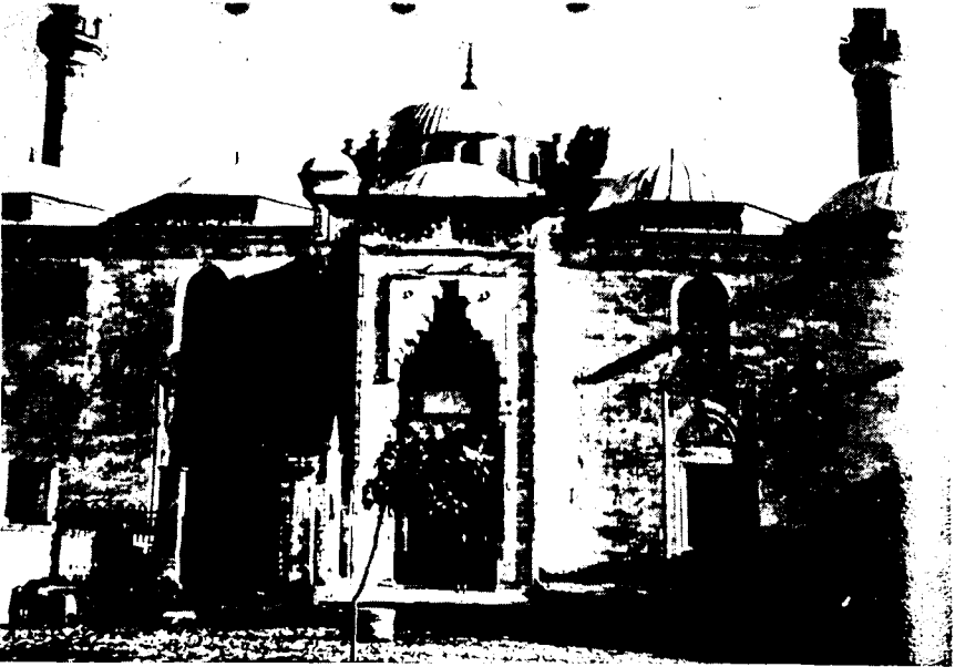
28 — Fatih Camii revaklı avlusunun esas kapı cephesi. Bu cephe pençerelerinin üstlerindeki kemerlerin içi porfir üzerine mermerle kakma olarak nefis sülüs hatla yazılar yazılmıştır. Pençerelerin etrafi kâmilten molürdür.
