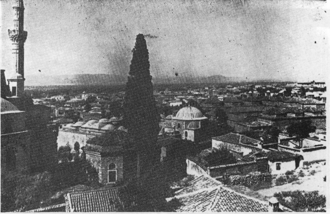
Resim 19 — Muradiye Medresesi ve kütüphanesinin güneyden görünüşü. (Vakıflar Gnl. Md. lük Arşivi)
