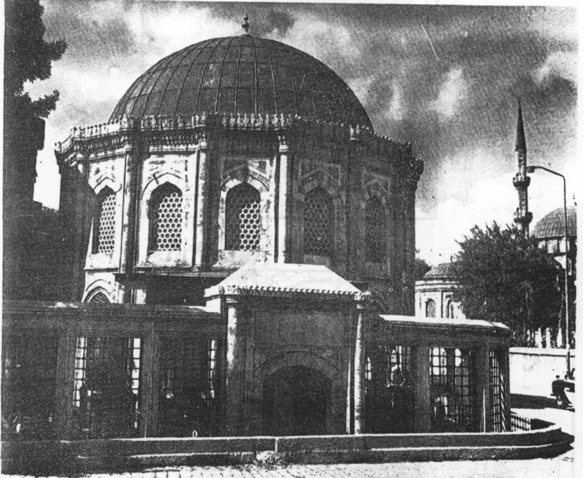
Res. 1 — Eyüp'te Ferhat Paşa Türbesi.
