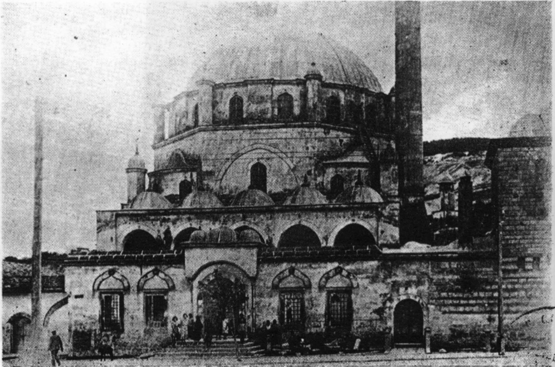
Res. 7 — Şumnu Şerif Paşa camii ön cephe
