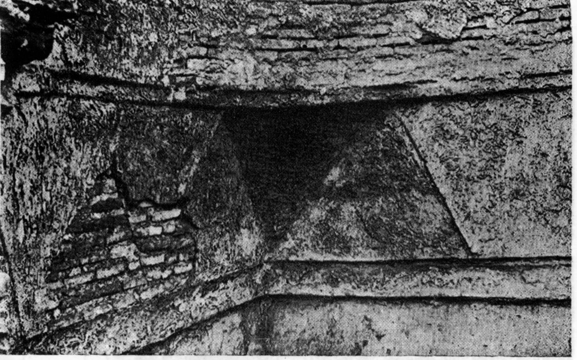
Resim 6 — Köşe halvetinde kubbe üçgenleri
