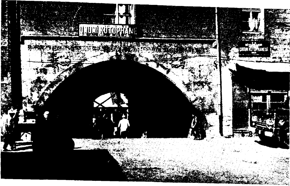
Res. 9 -- Diyarbakır Ulu Camii doğu tarafındaki esas giriş kısmı
