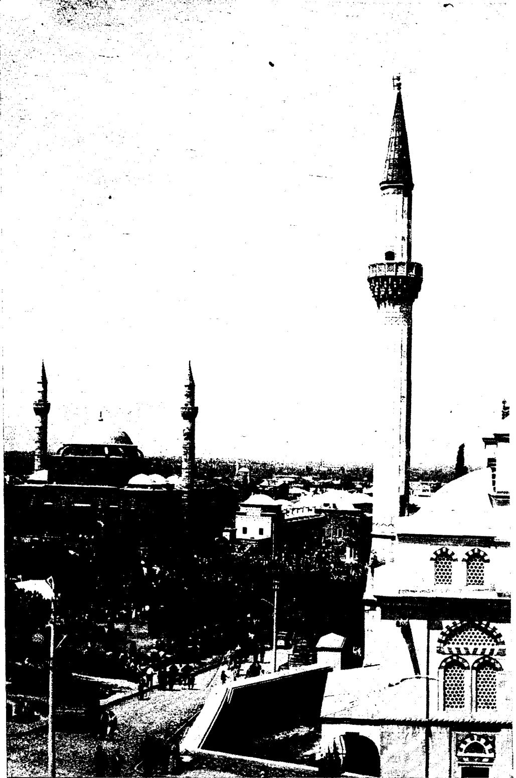
Res. 5 — Manisa Sultan Camii ve kısmen Muradiye camii.
