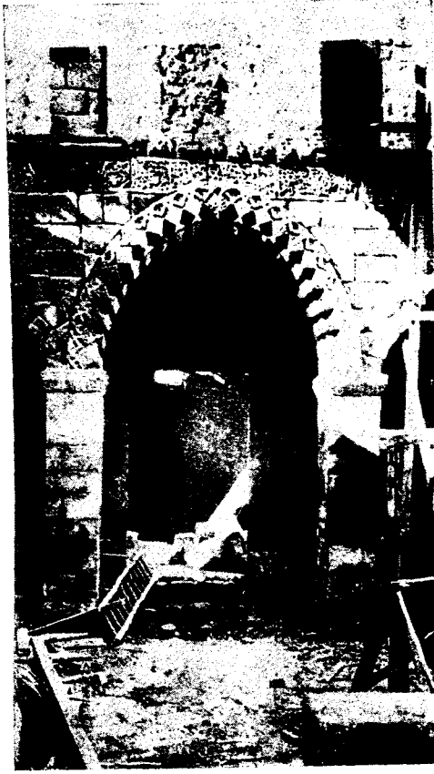
Res. 7 — Mesudiye Medresesi, avludan batı cephe.
