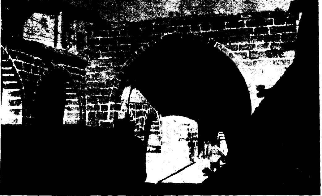
Res. 36 — Diyarbakır Ulu Camii mimari manzumesinden, abdestlik binası giriş kısmı
