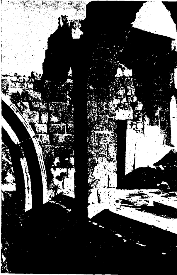
Res. 44 — Diyarbakır Ulu Camii mimari manzumesi Mesudiye Medresesi üst kat revakları
