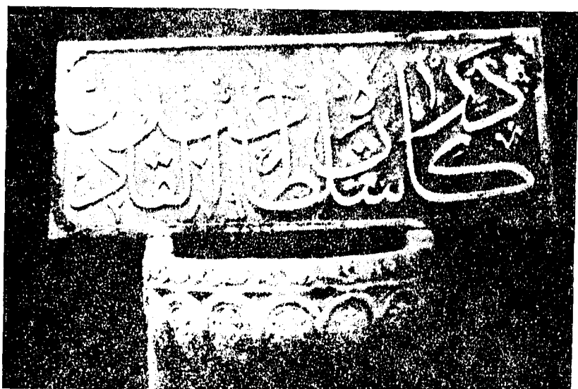
Res. 21 Mimar Ayas Camii duvar kitâbesi
