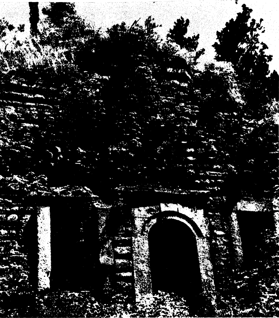
Res. 16 -- Onarım öncesi kütüphanenin arka cephesi.
