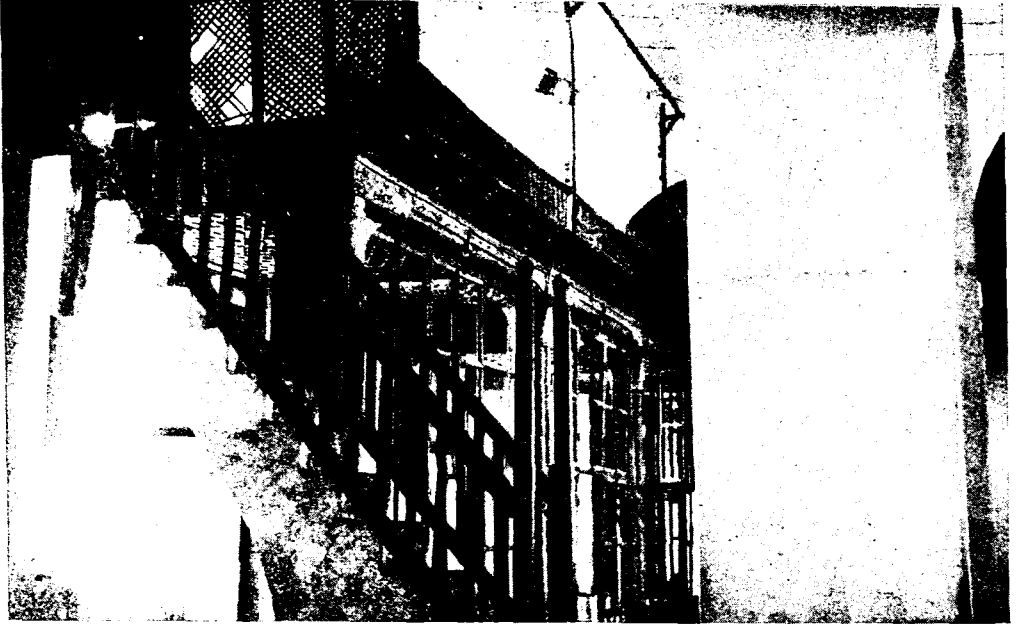
Res. 5 — Diyarbakır Ulu Camii harım kısmındaki ahşap müezzin mahfeli (H. 1124 tarihinde yapılmıştır.)
