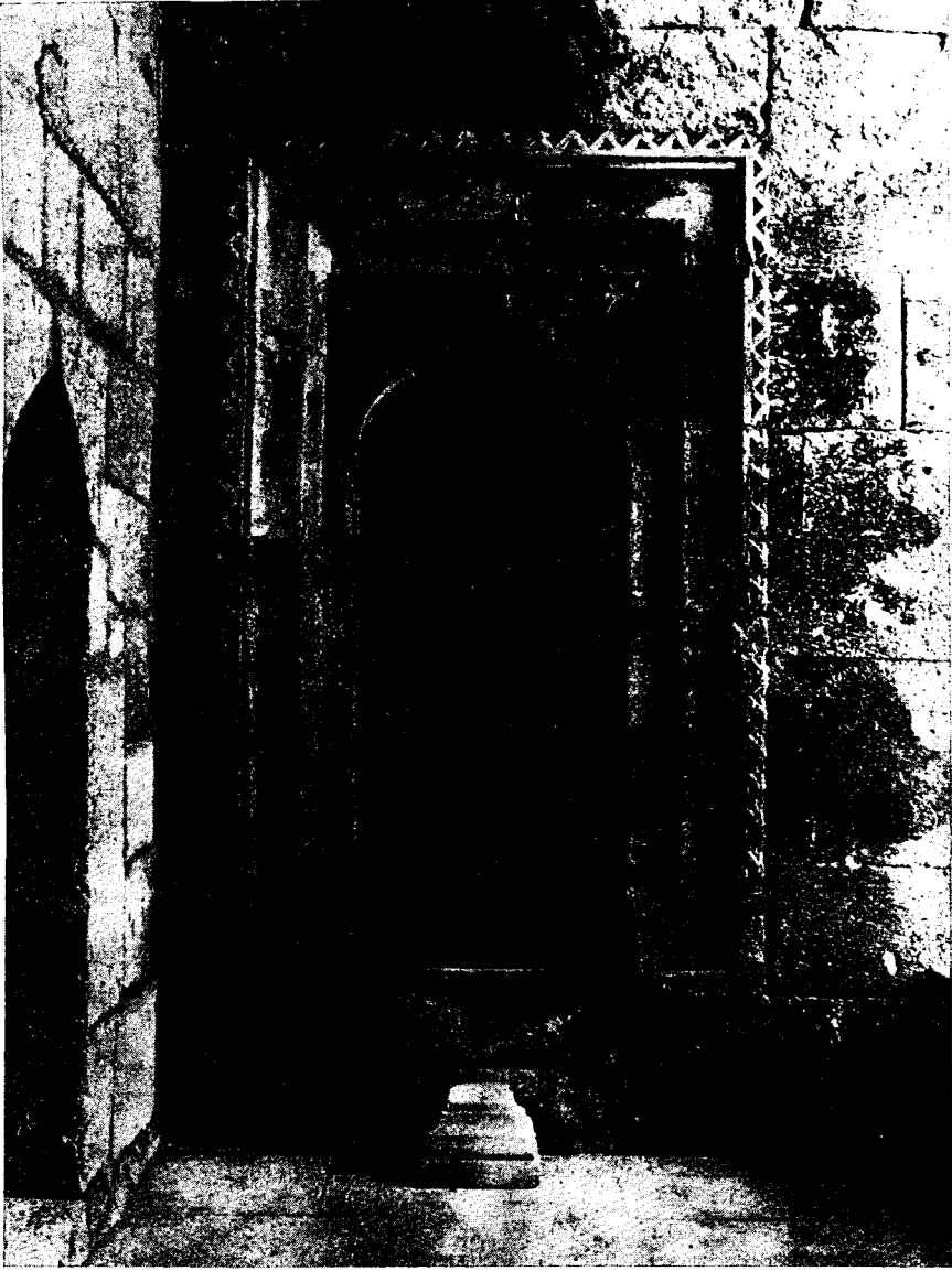
Res. 29 — Ak Medrese. atıya ıkan merdivenin kapısı.
