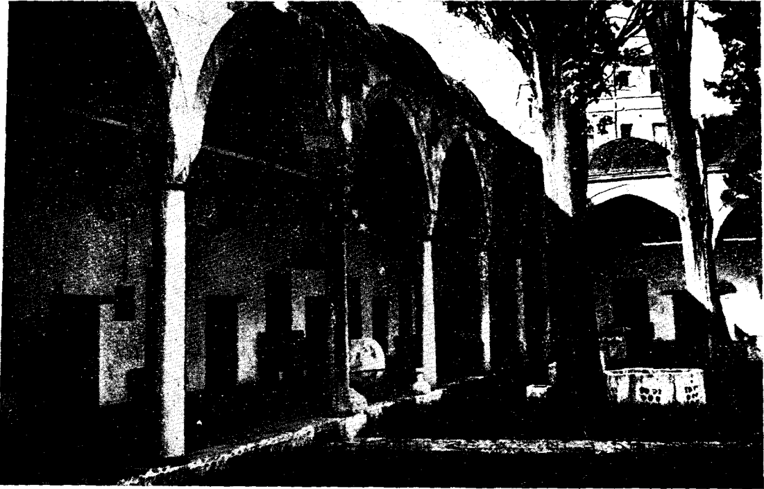
Res. 29 — Onarım sonunda medrese hücrelerinden dershane - mescit tarafındaki bölüm (Fot. Y. Önge)
