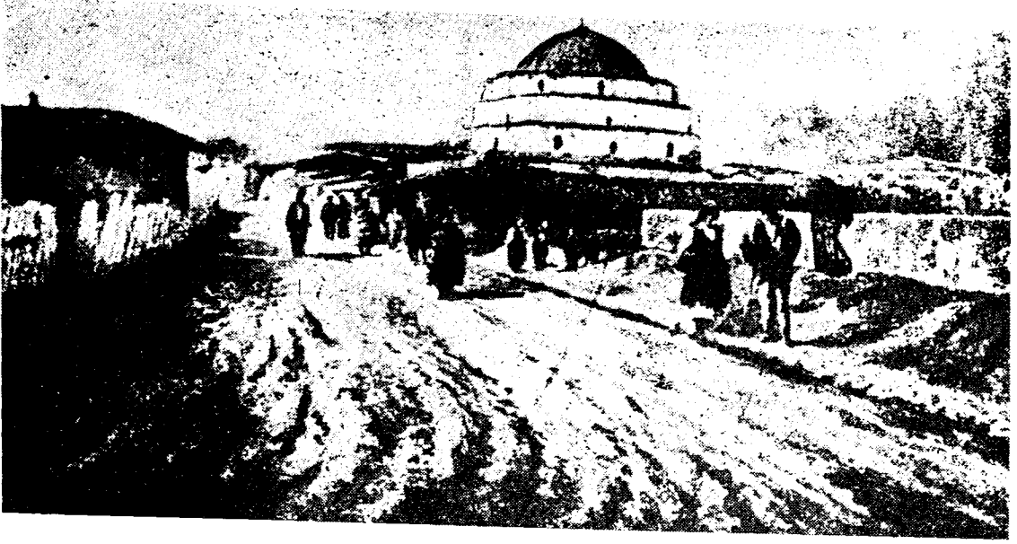
Res. 3 — Sofya'da Sofu Mehmet Paşa Cami Minareleri yıkılmış halde
