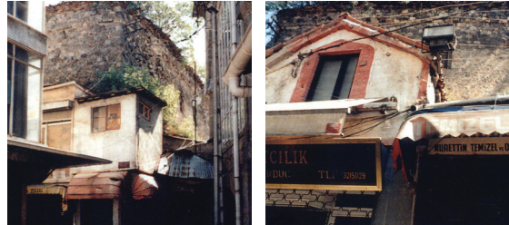
Resim 6. Güneybatı cephesi (Trabzon, K.V.K.K. Arş.)
