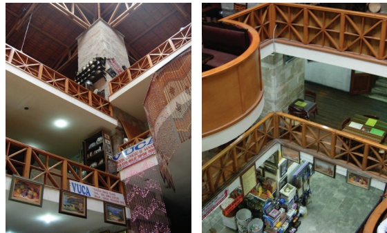
Resim 21. Restorasyon sonrası birinci ve ikinci kat görünümü (H. Emre Engin, 2010)
