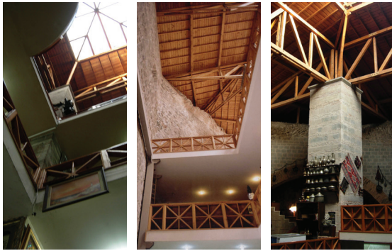
Resim 17. Restorasyon sonrası çatının duvar ve payeler ile ilişkisi (H. Emre Engin, 2010)
